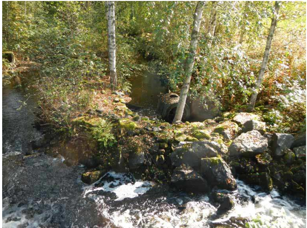
Kuva 48. Vesimyllyn rakenteita kuvattuna pohjoisesta sillalta. Turbiini koivun takana kuvan keskellä.
