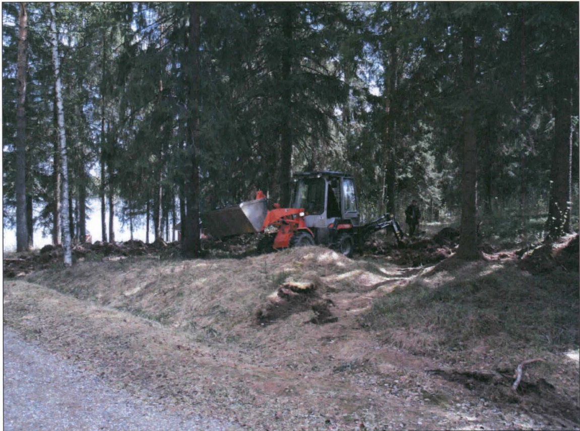
Kuva 11. Kiuruvesi Mäntyniemi kaava-alue. Konekaivuu käynnissä.
