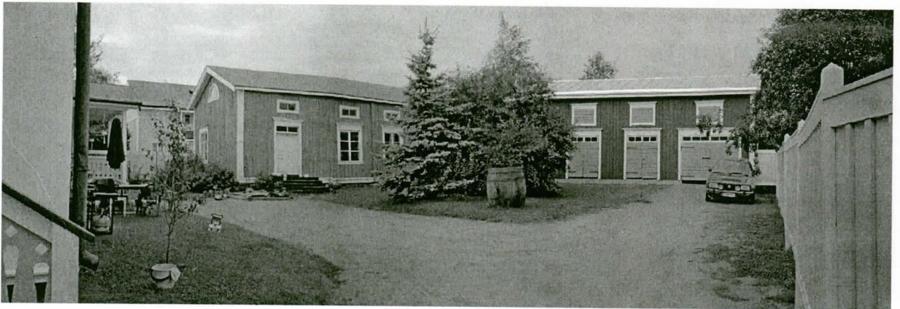
124641: 49-51. Tontti 3-8-152 sijaitsee 1600-luvun alkupuolen kaupunkialueen pohjoisimmassa korttelissa. Tontin kerrostumat ovat todennäköisesti tuhoutuneet ainoastaan uuden ulkorakennuksen alta (kuvassa oikealla). Kohti W.
