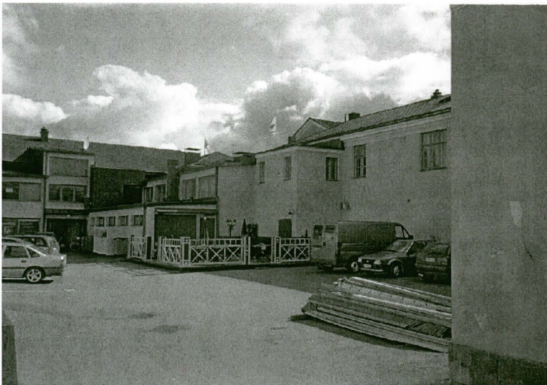
124641: 20. Tontin 2-14-3 sisäpiha on ollut rakennettua kaupunkialuetta jo 1600-luvun alkupuolelta. Kerrostumat ovat säilyneet alueella todennäköisesti vain osittain. Kohti E.
