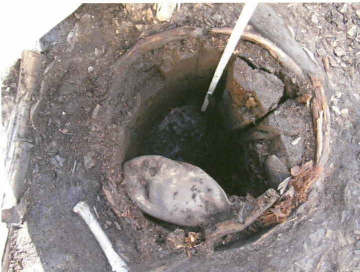
Lähikuva, R201 sammio, tiilet ja osa puita poistettu, kuvaaja Terhi Tanska
