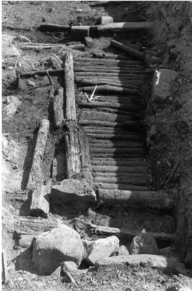
Kuva 28. R212 riukutasoa ja sen vasemmalla puolella R109 tukitason hirsiiä, joista toinen osittain poistettu.
