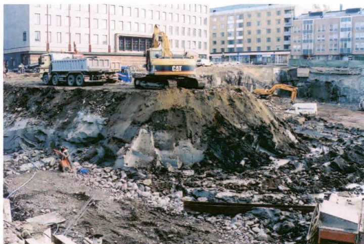
Kuva 31: Ajotien poistoa. Kuva M. Kykyri KyMM.
