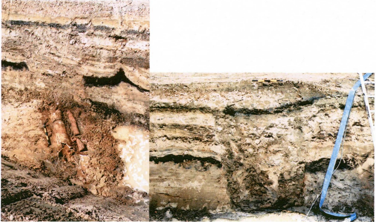
Kuva 25 (vasemmalla): Viemäri- ja salaojakaivannon pohjaa. Kuva 26: Viemärikaivanto.
