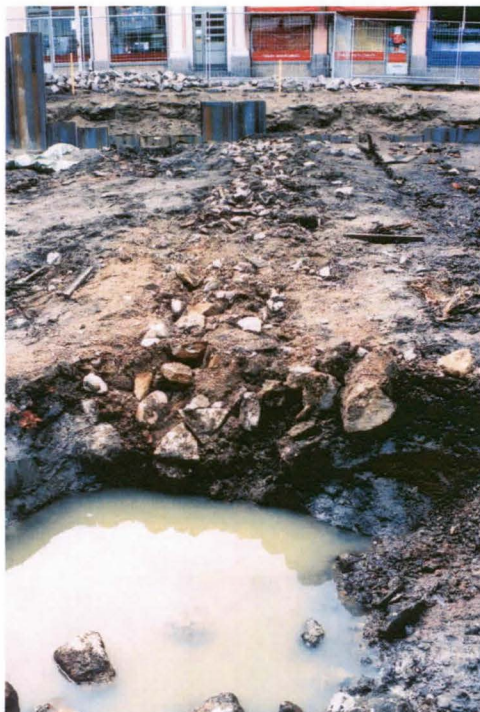
Kuva 14: Kivitäytteen salaojan pintaa. Kuva M. Kykyri KyMM.
