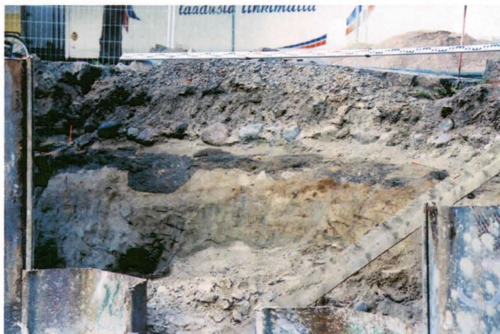
Kuva 30: Pohjamaahan kaivettu tasapohjainen avo-oja. Kuva M. Kykyri KyMM.
