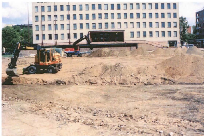
Kuva 5: Torin mukulakiveyksen pintaa kaivetaan esille koneellisesti. Kuva M. Kykyri KyMM.
