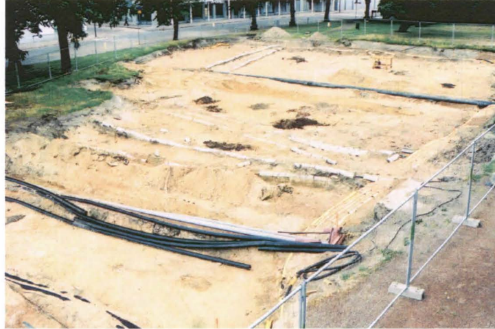
Kuva 6: Valakallionpuisto pintamaan poiston ja koeojien kaivamisen jälkeen. Kuva M. Kykyri KyMM.
