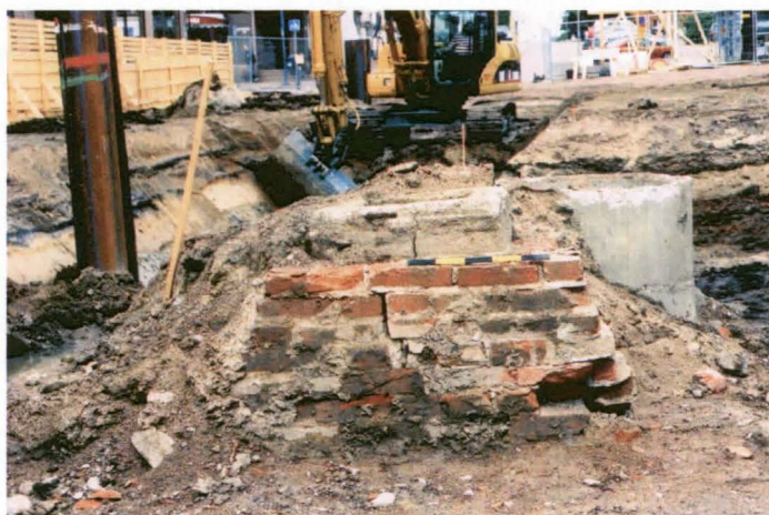
Kuva 17: Vierekkäin sijainneet tiili- ja betonikaivo. Kuva M. Kykyri KyMM.
