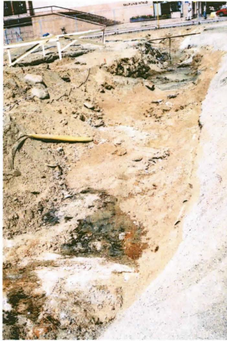
Kuva 9: Linja 1. Lohkokivitäyttöä ja räjäytettyä kallionpintaa. Kuva M. Kykyri KyMM.
