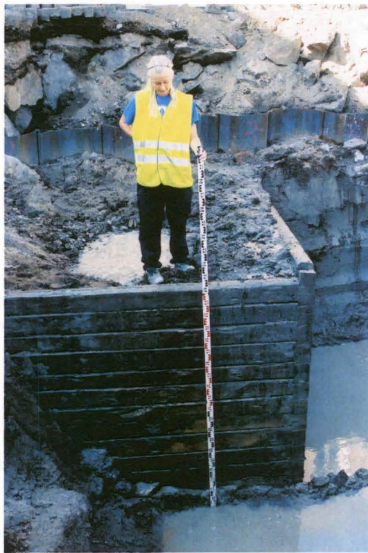
Kuva 12: Larsen 1 alueella sijainnut hirsikaivo esille kaivettuna. Huomaa taustan maaseinämän lohkokivitäyttö. Kuvassa Pauliina Posti lattatyttönä. Kuva M. Laitala KyMM.
