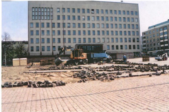
kuva 4: Torin nupukiveystä poistetaan koneellisesti torin keskusta. Kuva M. Kykyri KyMM.
