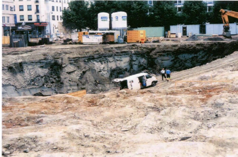
Kuva 32: Ajotien SE-seinämää ja sen yläosassa erottuvat kaksi päällekkäistä orgaanista horisonttia. Kuva M. Kykyri KyMM.
