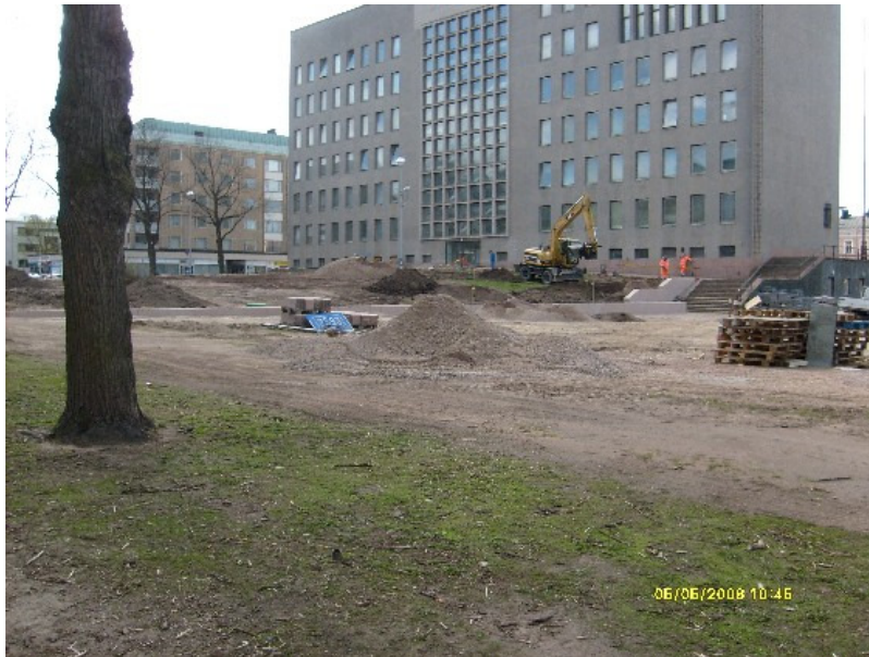
Kuva 4: Valakallionpuiston kunnostustyöt käynnissä kesäkuun alussa puiston pohjoisnurkasta kuvattuna. Kuva: KyM/M. Kykyri.
