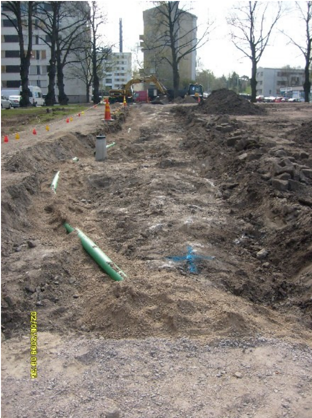
Kuva 10: valokaapelikaivanto 4 pohjaan kaivettuna. Kaivannon pohjalla näkyy räjäytetyn peruskallion epätasaista pintaa. N. KyM/M. Kykyri.
