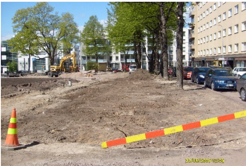
Kuva 6: valokaapelikaivanto 3:n aluetta kaivetaan. SE. Kuva: KyM/M. Kykyri.
