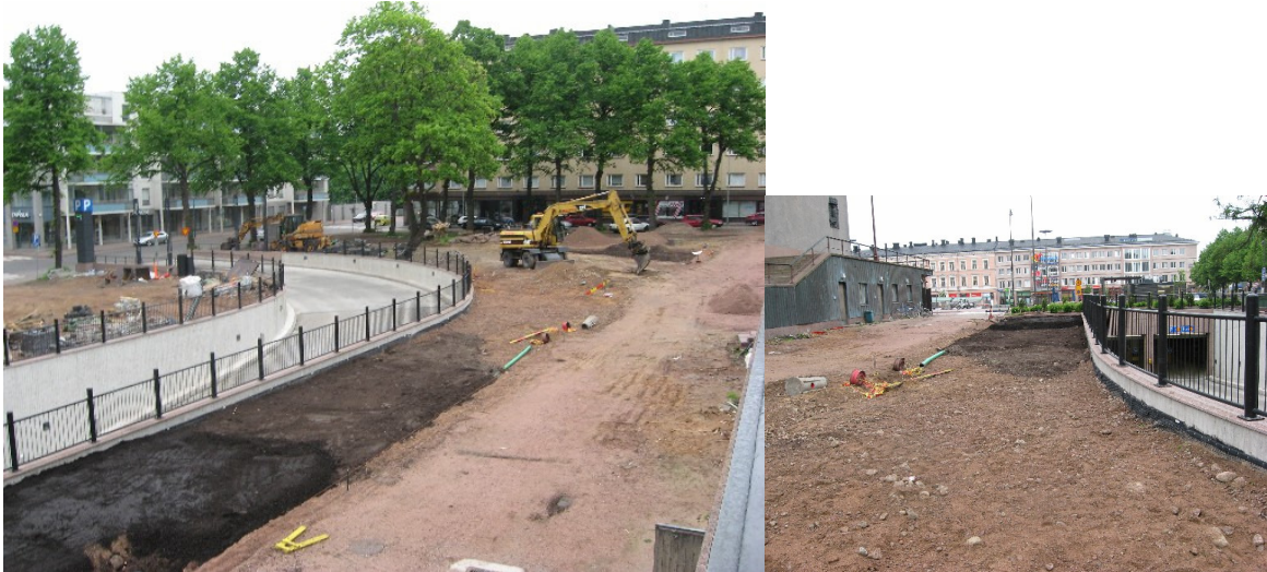
Kuvat 13-14: kaapelikaivanto työn alla. Kuoritun pintamaan paikalle siirrettiin uutta multaa yhteensä 40-50 cm paksuudelta. Kuva 13 (vas.) suunnasta S ja kuva 14 suunnasta NE. Kuvat KyM/M. Kykyri.
