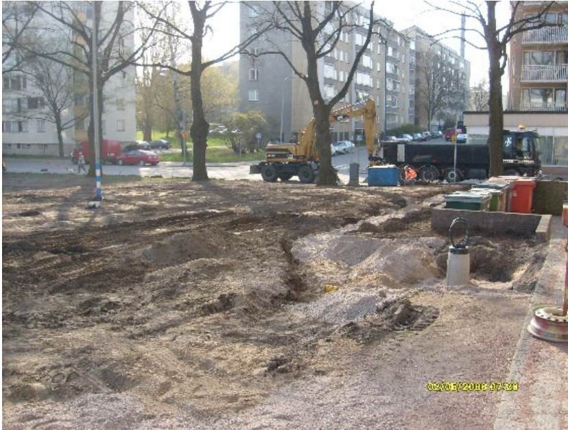
Kuva 5: täytetty valokaapelikaivanto 1 erottuu selvästi sitä ympäröivästä tummasta multakerroksesta. W. Kuva: KyM/M. Kykyri.
