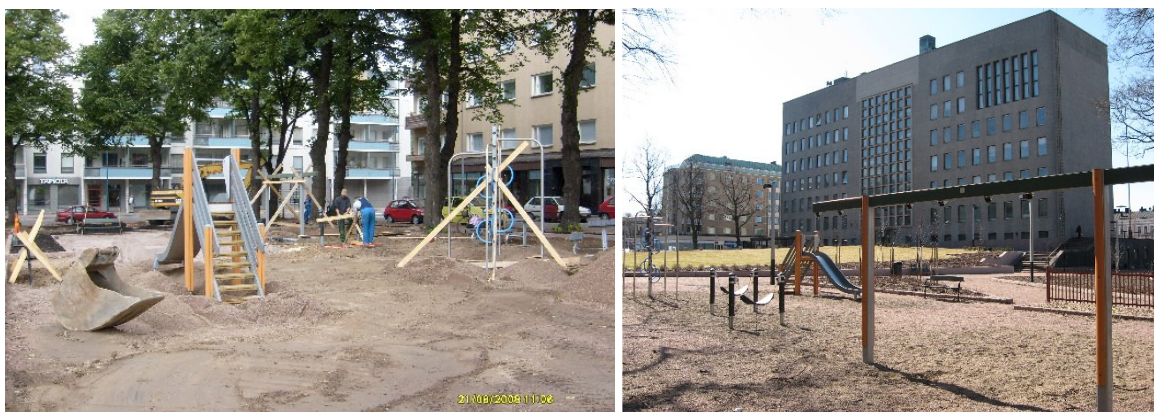
Kuva 27-28: leikkialue rakenteilla (vas. suunnasta S) ja valmiina (oik. suunnasta N). KyM/M.Kykyri.
