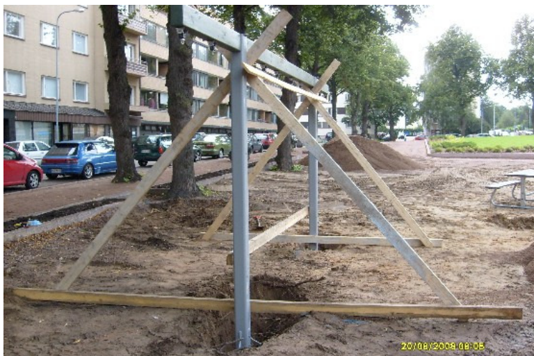
Kuva 29: keinua varten kaivetut telinekuopat MP1 ja MP 2 ja niihin paikalleen asennettu teline ennen betonivalua. NW. KyM/M. Kykyri.
