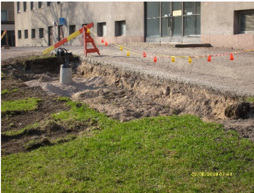
Kuva 9: valokaapelikaivanto 2 osittain peitettynä. N. KyM/M. Kykyri.
