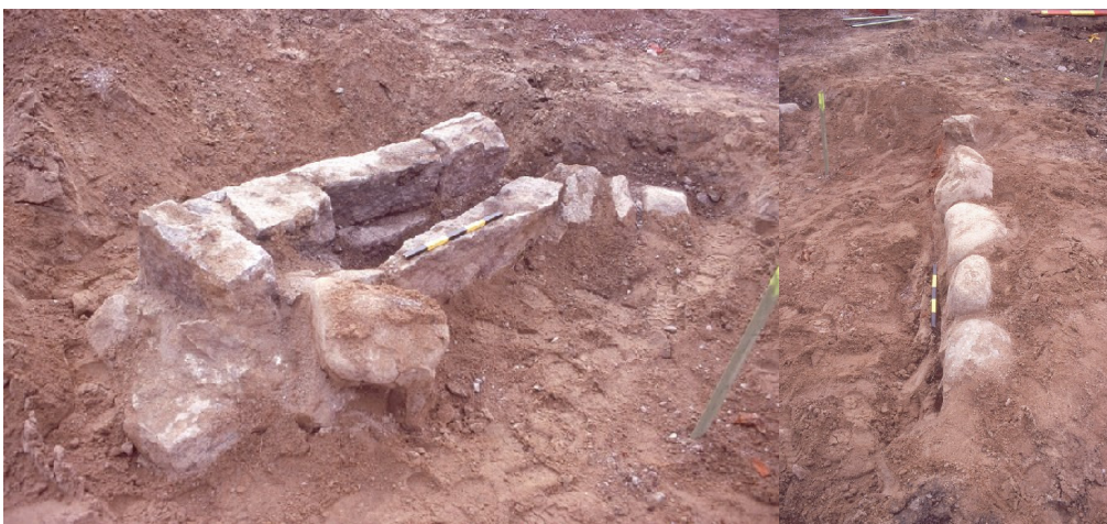
Kuvat 16-17: vasemmalla perustus 1 (W) ja oikealla perustus 2 (SE) ennen multakerroksella peittämistä. KyM/M. Kykyri.
