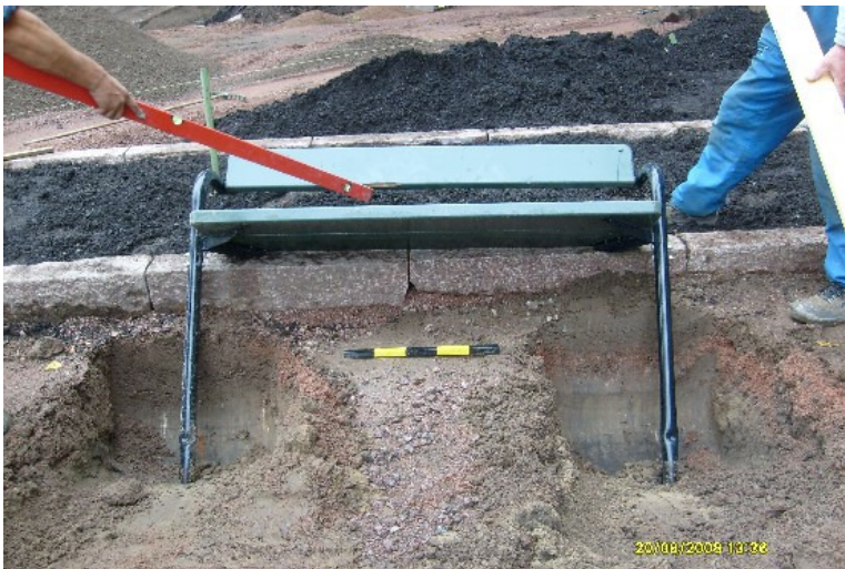
Kuva 32: puistopenkkiä asetetaan paikoilleen telinekuoppiin. SE. KyM/M. Kykyri.
