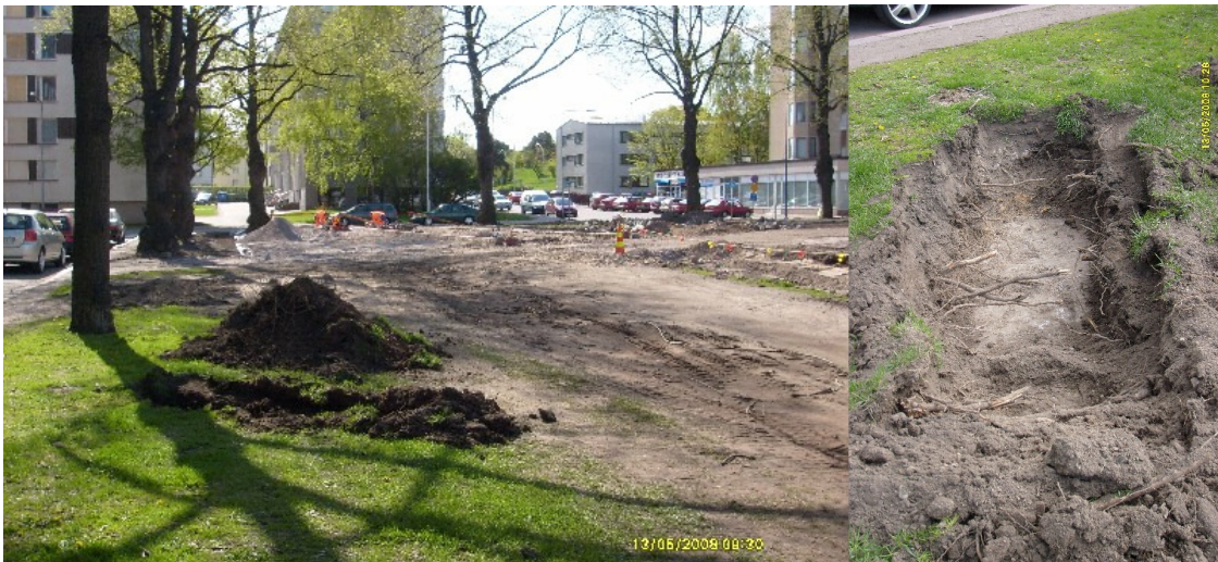
Kuvat 11-12: koekuoppa 2 kaivettiin Rauhankadun jalkakäytävän tuntumaan puiston NE-sivustalle (vasemmalla NW:stä). Oikealla koekuoppa kallion pintaan kaivettuna. W. KyM/M. Kykyri.
