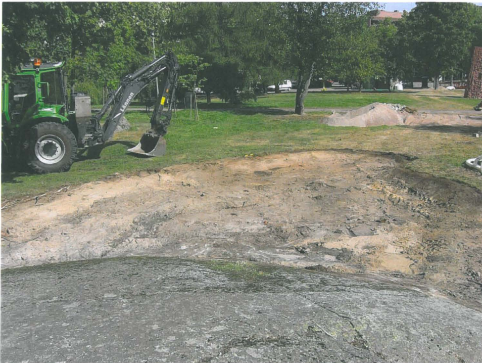
Kuva 14: Kosteikkoallas pohjaan kaivettuna. Altaan alueella oli säilynyt Ruotsinsalmen aikaista kulttuurikerrostumaa löytöineen, mutta se jätettiin maaperään paikoilleen lähes koskemattomana. S. KyM/M. Kykyri.
