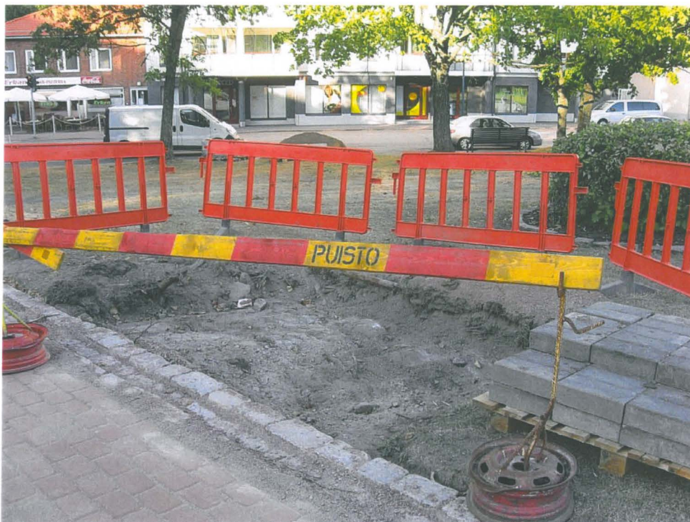
Kuva 10: K 501:n paikka kun vanha betonitiilikate on poistettu. SW. KyM/M. Kykyri.
