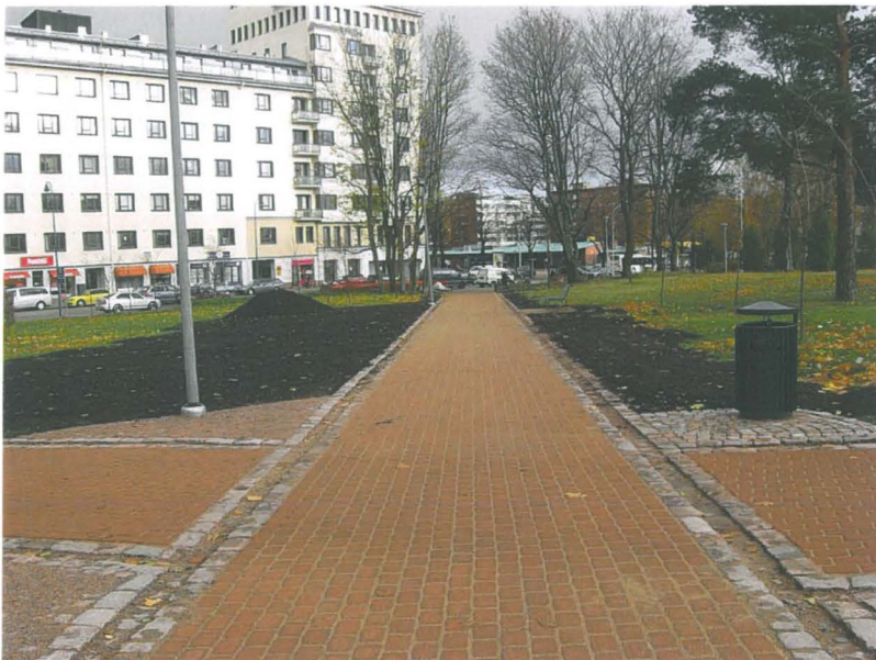
Kuva 23: Käytävä 2 saneerattuna. Käytävän eteläsivustalla (oik.) näkyy myös saneeratut kohteet K 503 sekä kauempana K 507. Käytävän pitkille sivuille on levitetty paksu kompostimultakerros. W. KyM/M. Kykyri.
