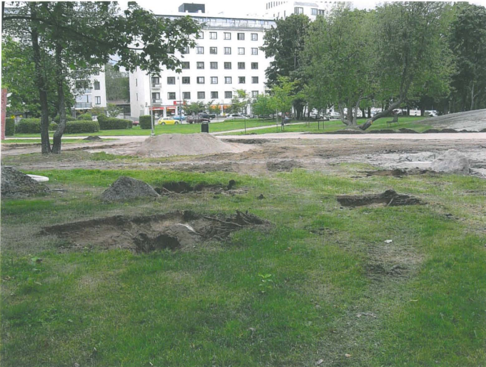
Kuva 15: Puunistutuskuopat MP 16-19 ennen dokumentointia. Oikealla näkyy samaan puistolohkoon käytävä 3:n länsipuolelle kaivettua kosteikkoallasta. SW. KyM/M. Kykyri.
