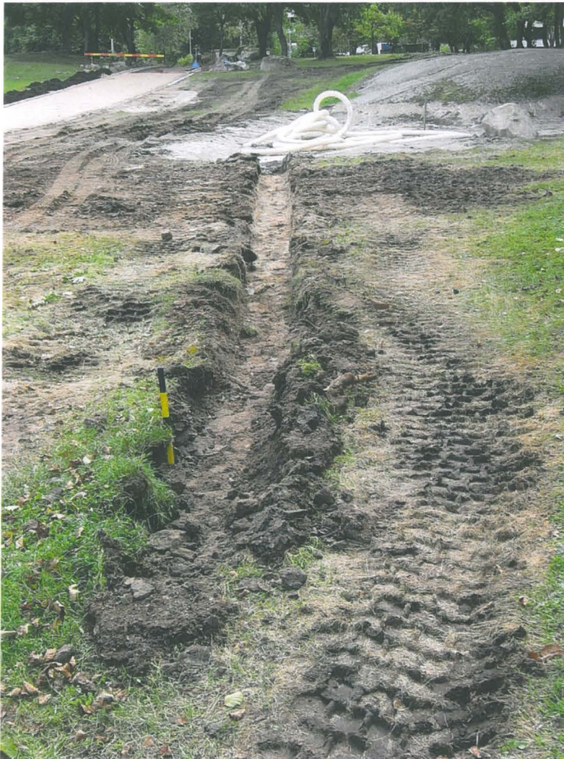
Kuva 18: Salaoja 2 pohjaan kaivettuna. Taustalla pohjaan kaivettu ja savettu kosteikkoallas. NW. KyM/M. Kykyri.
