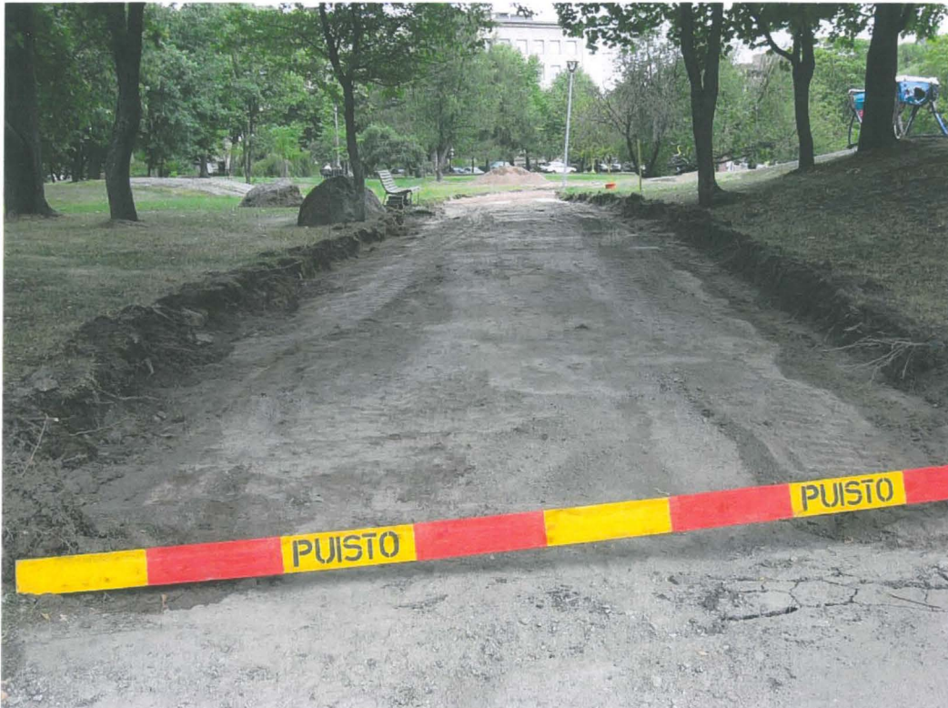
Kuva 13: Käytävä 3:n keskiosaa lopullisessa kaivussyvyydessään. Asvaltin alle levitetty vanha pohjustushiesu on jätetty paikoilleen ja ainoastaan puistokäytävän reunoja on levennetty ja syvennetty sinne asennettavien nupukivisten vesiurien vuoksi. S. KyM/M. Kykyri.
