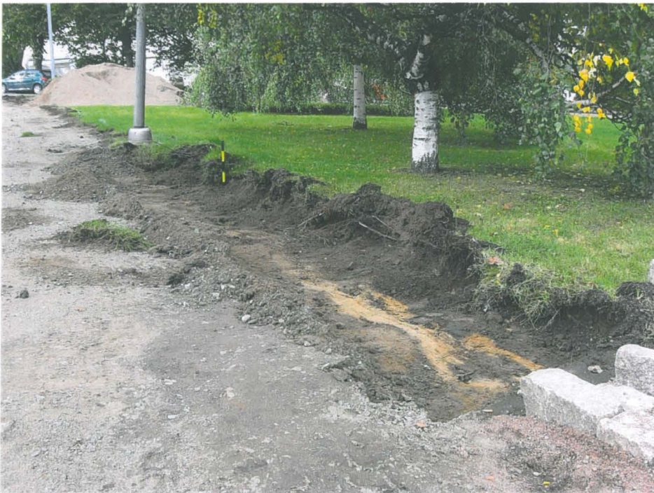
Kuva 25: Käytävän N-seinämaa esiin kaivettuna. Multakerrosten ja asvaltin pohjustushiesun alla näkyy rautaoksidipitoisen kellertävän hiesukerroksen pintaa. Mittatikku on maapilari MP 24:än kohdalla. Oikealla alakulmassa on esillä valmiiksi asennettua nupukivistä vesiuraa. NE. KyM/M. Kykyri.
