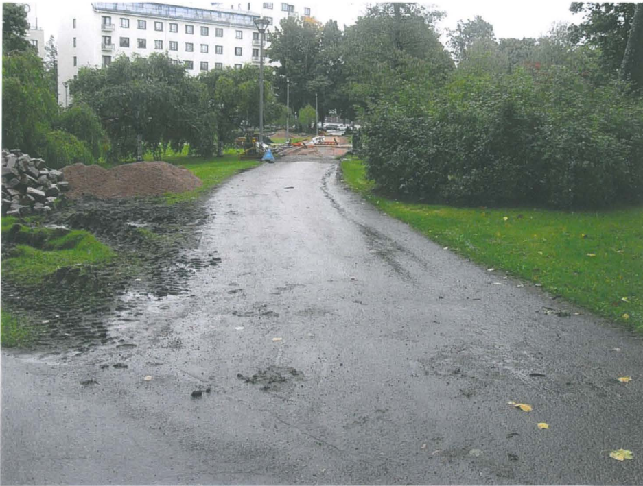
Kuva 24: Käytävä 4 ennen saneerausta ja asvaltin poistoa. W. KyM/M. Kykyri.
