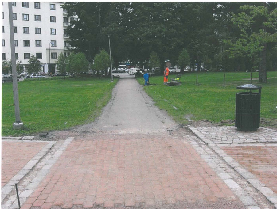
Kuva 20: Käytävä 2 ennen asvaltin poistoa. Oikealla saneerattu roskakorin paikka K 503. Taustalla J. Matilainen ja J. Uotinen poistavat puistonpenkin K 507 vanhaa betoniilikatetta. W. KyM/M. Kykyri.
