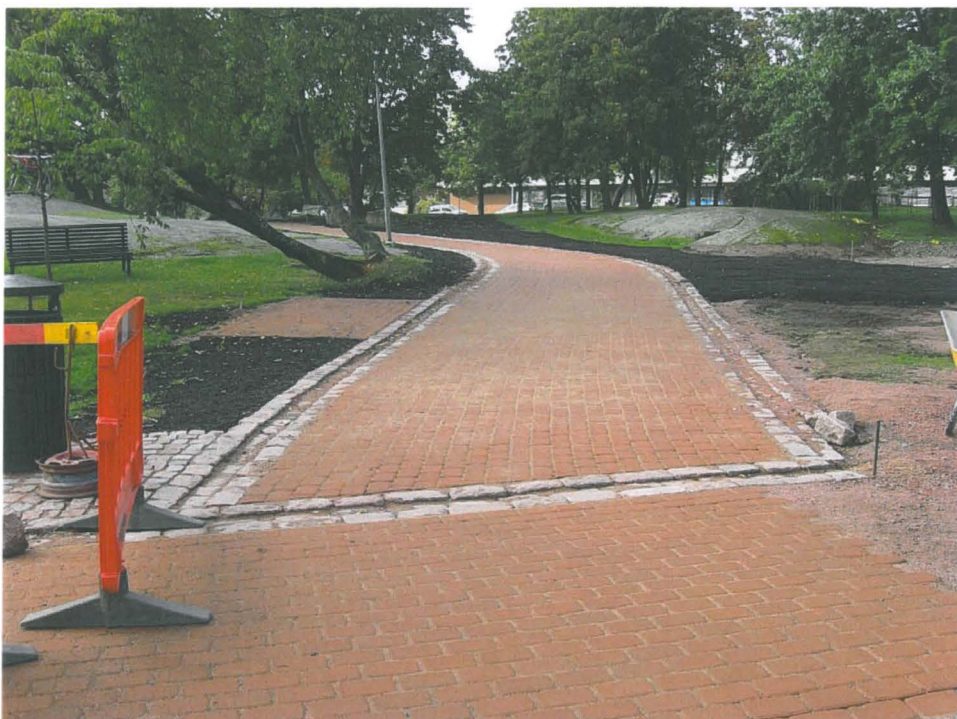
Kuva 19: Käytävä 3:n N-pää saneerattuna. Kuvassa näkyvät vasemmalla myös saneeratut kohteet K 503-K 504: roskakorin ja puistonpenkin paikat. N. KyM/M. Kykyri.
