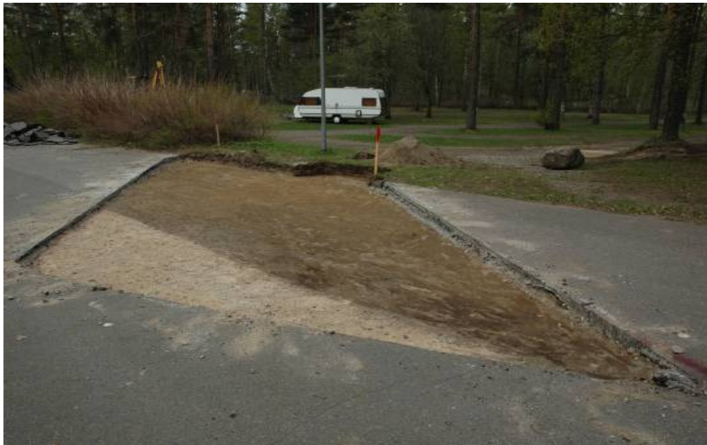
Digikuva 121. Alue 3 asfaltin ja sen alla olevan sepelin poiston jälkeen. Vaaleampi hiekkakerros kuvan etuosassa oli ilmeisesti myöhempää täyttömaata, jonka paksuus oli noin 10 cm. Sen alla oli samaa sekoitettua pintamaata, joka näkyy kuvan taustalla
