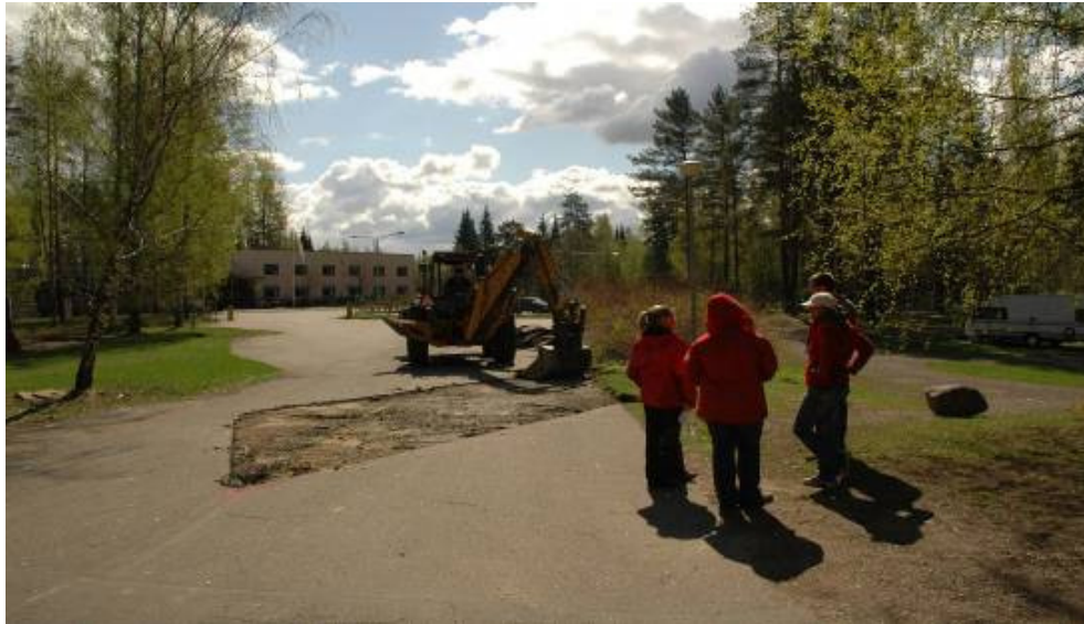
Digikuva 103. Työkuva. Asfaltin poistoa alueelta 3.
