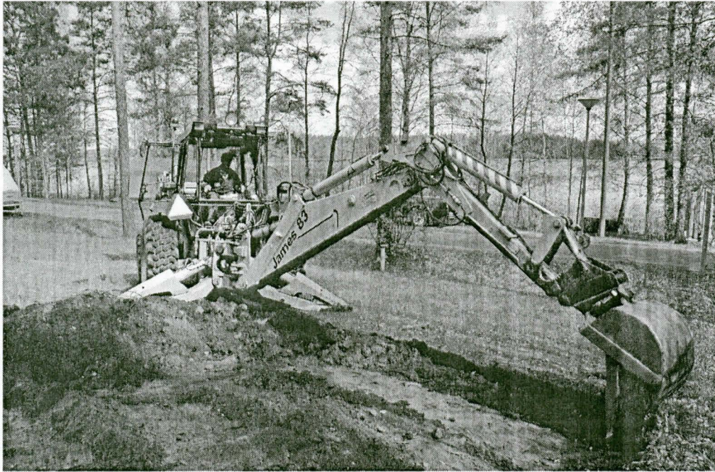
Kuva 1. Lappeenranta, Huhtiniemi, pintavesilaitos. Koekuoppaa 1 kaivetaan. Kohti N. Kuva: O. Seitsonen.
