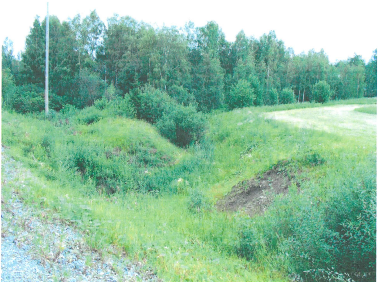
Kuva 15. Uutta "kanavaa" tien 190 itäpuolella. Kuvattu maantiesillalta itään. JR
