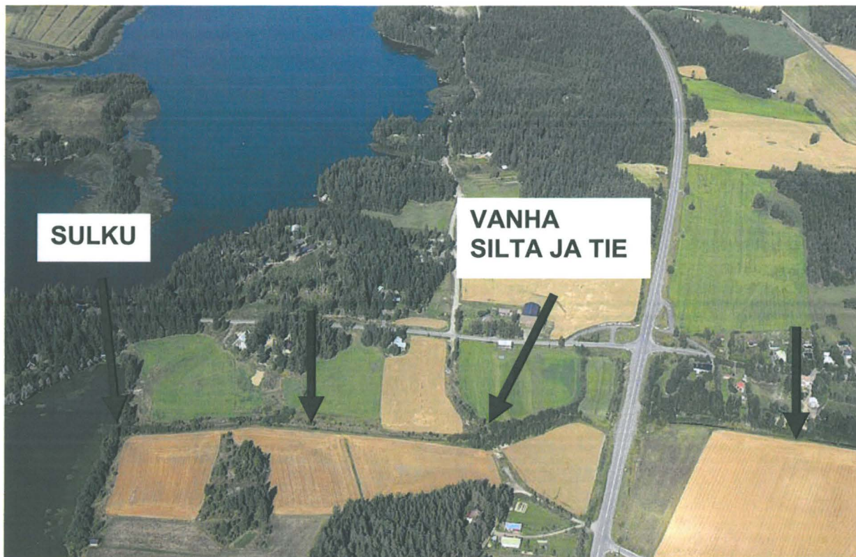
Kuva 1. Viistokuva Rikalan kanavan länsipäästä ( http://www.kuvat.lempaala.fi/ )
