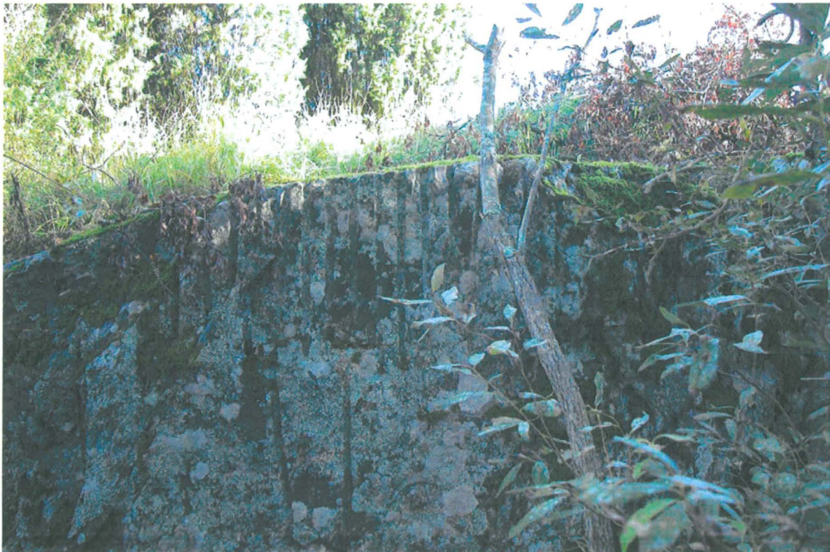
Kuva 2. Kallioon porattua sulun pystysuoraa pohjoisseinämää. Kuvattu pohjoiseen. TT
