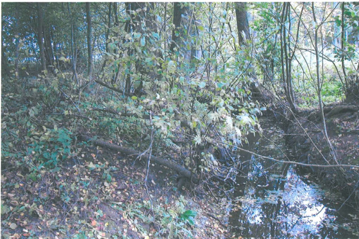
Kuva 17. Kanavan matalaa ja mutkittelevaa itäpäättyä. Taustalla Kortteselkä. Kuvattu itään. TT
