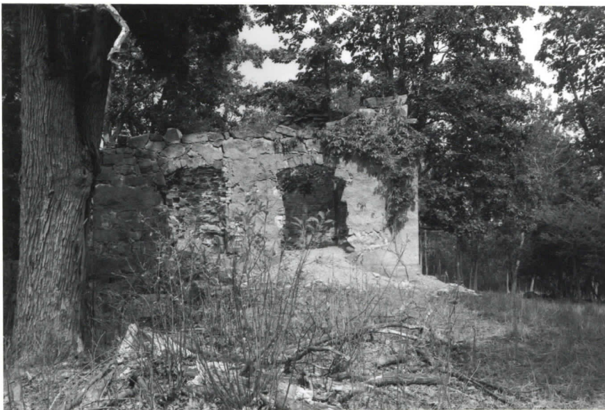
Kuva 39. Setolan vanhan päärakennuksen rauniot. (f.125459:57).
