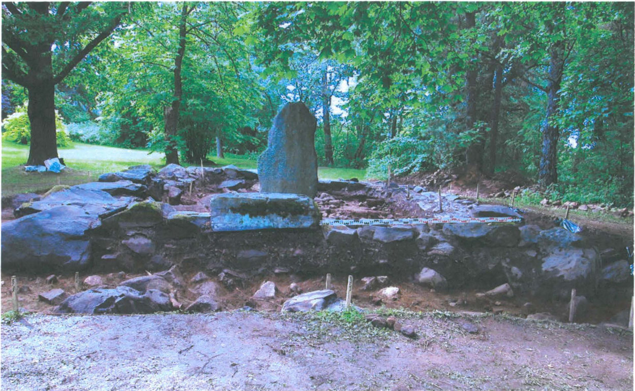
Kappelin itäseinän perustuksen ulkoprofiili (digikuva 71). Kuvattu itäkaakosta.
