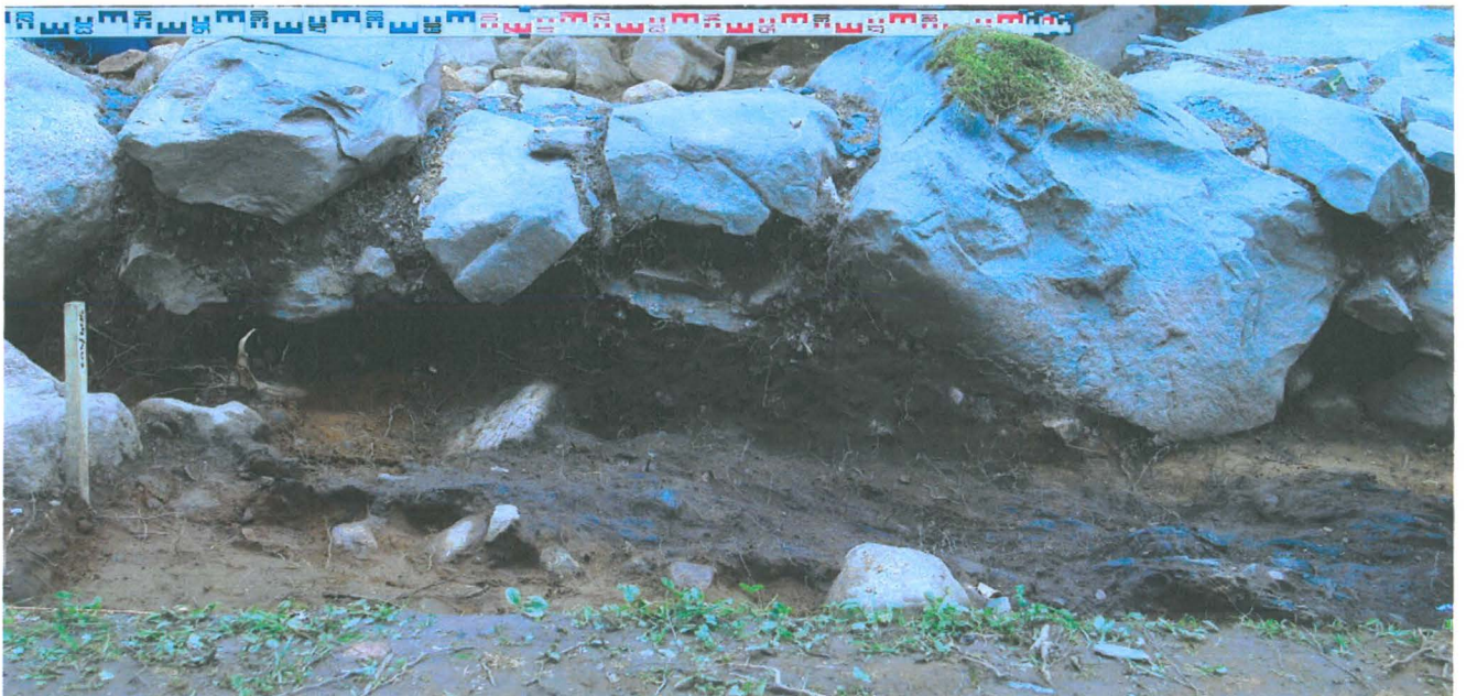
Kappelin eteläseinän perustuksen ulkoprofiilin itäosa; etualalla puurakenteen (R2:n) jäännös (digikuva 65). Kuvattu etelälounaasta.
