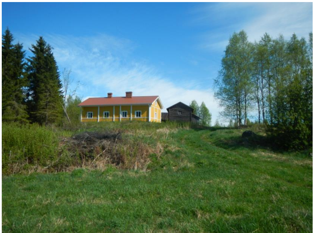
Kuva 10. Kemin päärakennus, kuvattuna etelästä.
