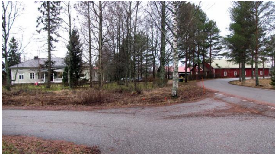
Kuva 16. Tuukkolan kylän Tuukkolan talo kuvassa vasemmassa laidassa, historiallinen tielinja oikealla.
