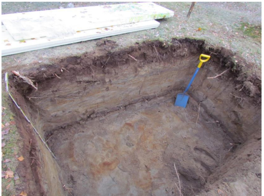
Kuva 9. Opastaulun asentamiseksi kaivettu kuoppa. Kuopan pohjalle asetettiin ylhäällä näkyvät levyt. Kuva: Kalle Luoto.
