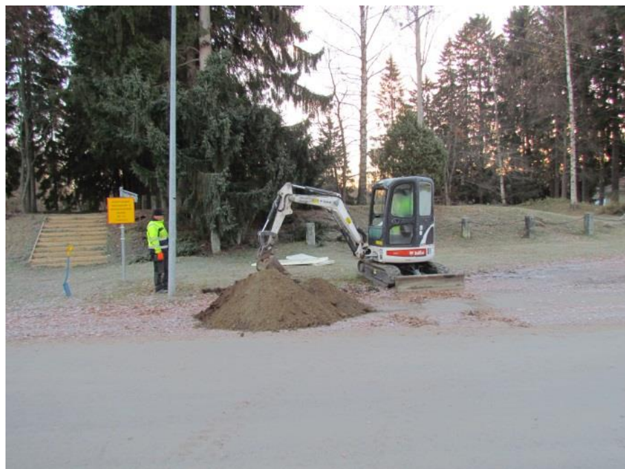
Kuva 1. Opastaulun kuoppaa kaivetaan lokakuussa 2013. Oikealla vanhoja tolppia. Kuva: Kalle Luoto.
