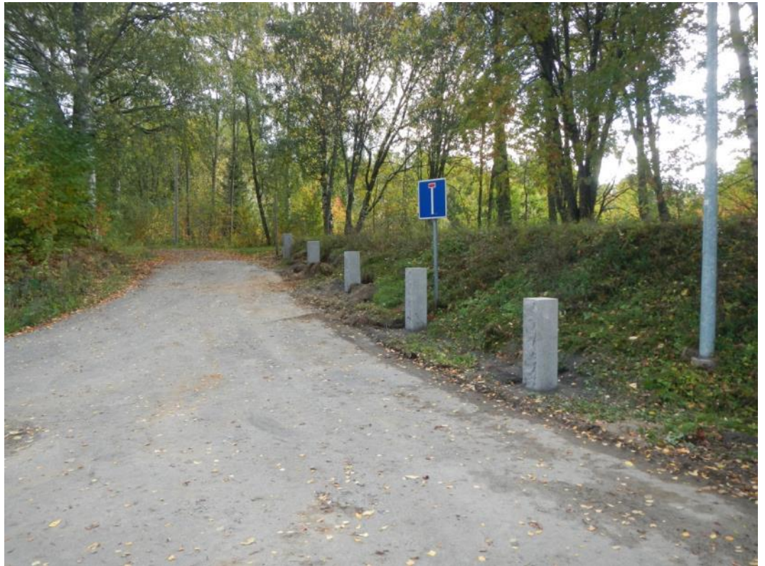
Kuva 8. Asennettua tolppa-aitaa kevyenliikenteenväylän reunassa. Kuva: Kalle Luoto.
