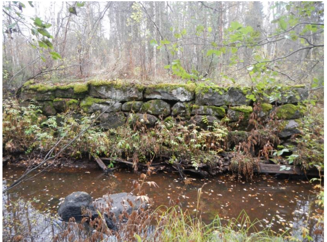
Kuva 10. Sahaan kuuluneen kivirakenteen perustus.
