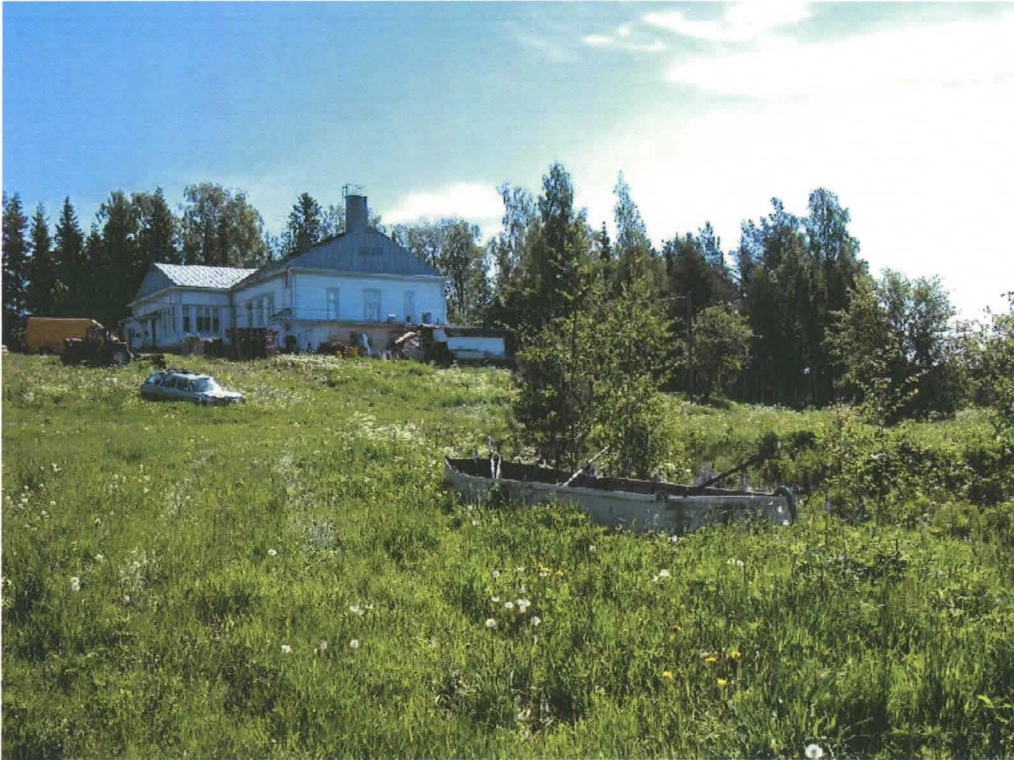
Kuva 4. Pappilan päärakennus. 8.6.2009, Kirsi Luoto.
