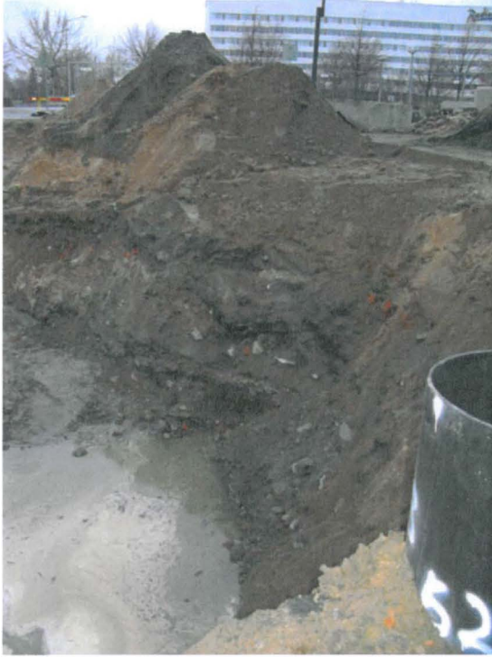
Kuva 1. Yleiskuva kaivannosta. Kuvattu koilliseen.
