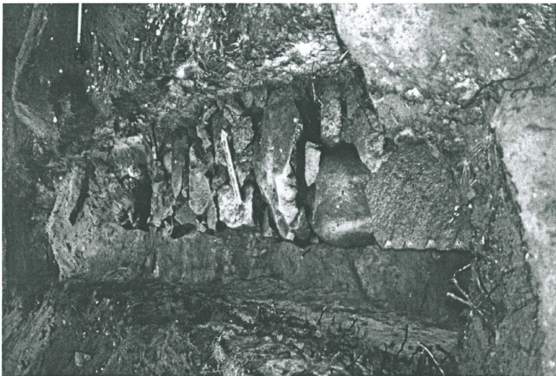
Kuva 2. Oulu Aleksanterinkatu 6. Koeoja 3, 1800-luvun rakennukset peruskiveys. Suunta 100. Kuvaa käännetty 90 astetta vasemmalle. (Oulun yliopiston arkeologian laboratorio, kuva nro. 23532).
