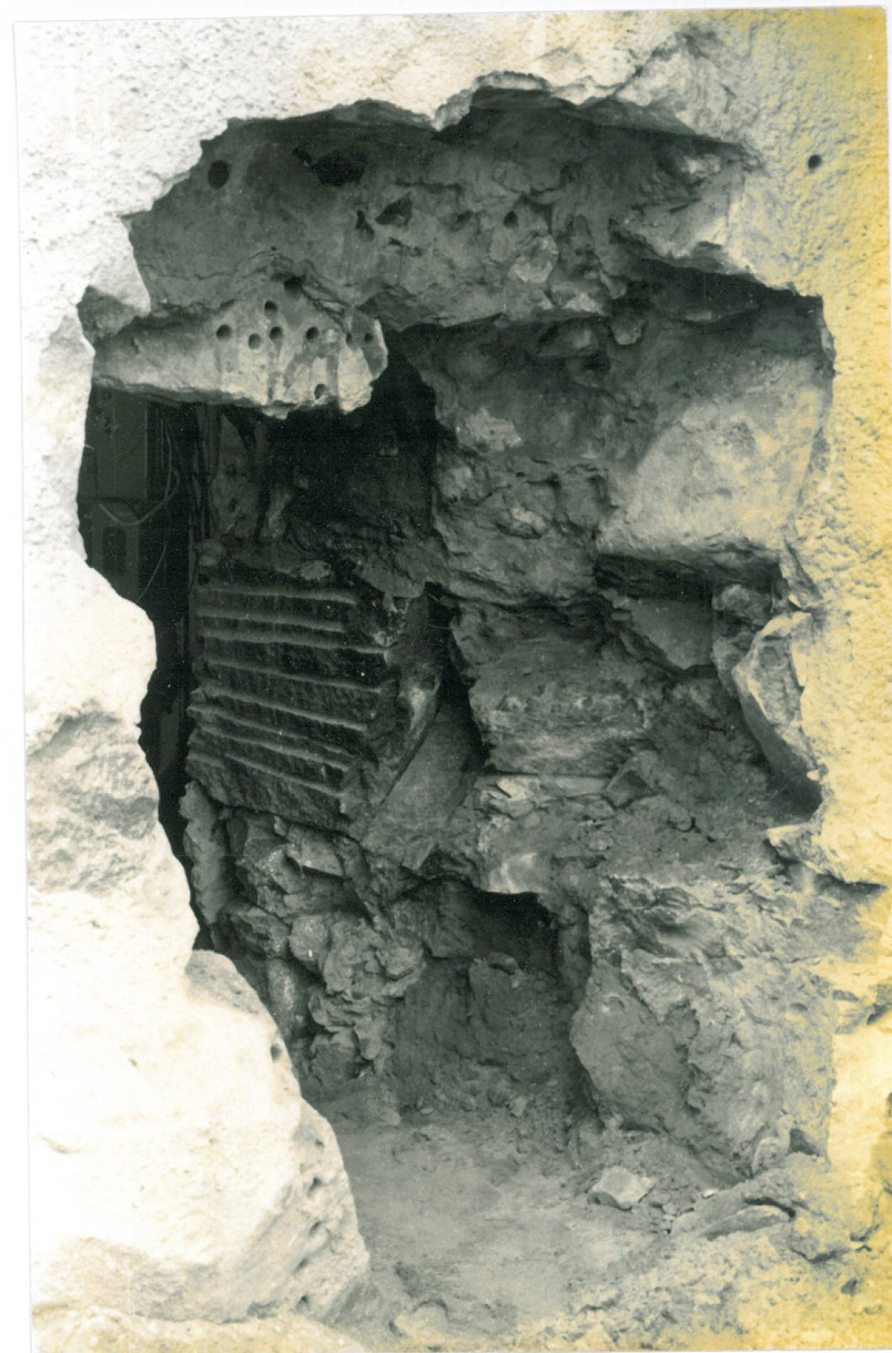
nega 34543 perusmuurin leikkaus kellariin tehdyn aukon pielestä 2.8.1996
