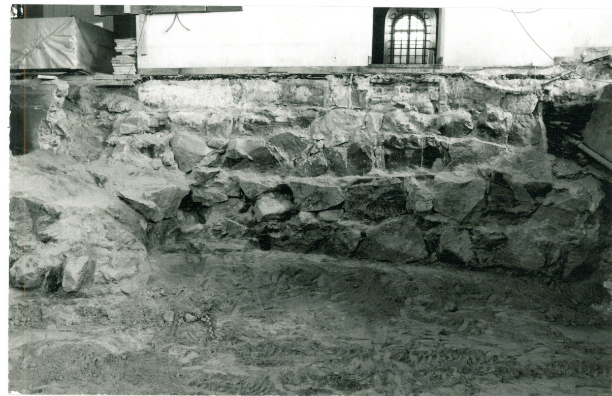
nega 34434 Sakastinpuoleisen seinän perusmuuria 7.8.1996
