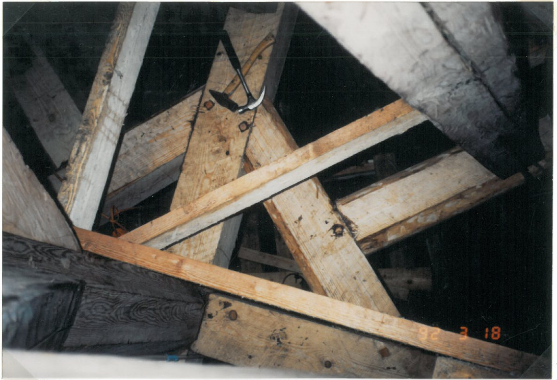
UUSITUSSA YLIMMÄSSÄ TASAKERRASSA ON LIITOKSET TEHTY TAPPI-SALVOKSINA. KUVASSA NÄKYVY MYÖS YLIMPIEN TUKIRAKENTEIDEN NOSTOA VARTEN LYÖTYJÄ SIDEPUITA. KUVA 9.
