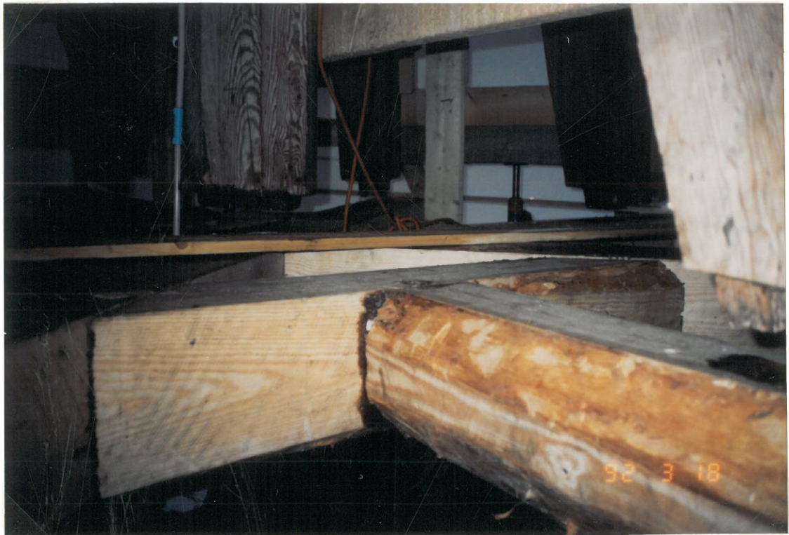
TORNIN YLIN OSA TUNKATTUNA YLÖS. KUVA 10.
