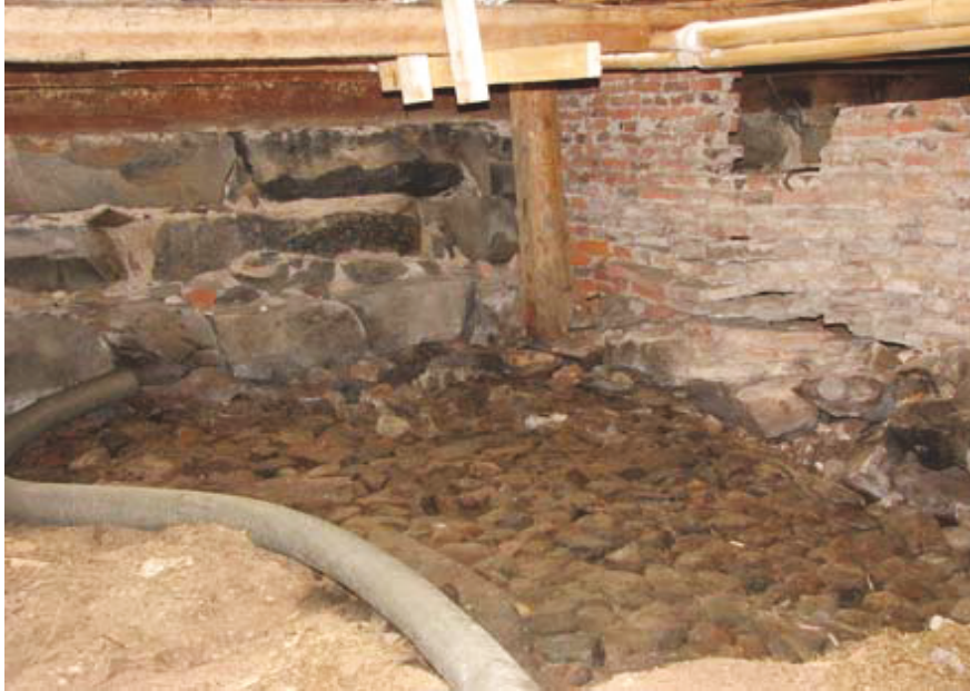
Kuva 34. Byströmin pohjoistalon itäisen kivijalan läheisyydessä ollutta kivitasa, joka puhdistettu imurilla. Kaivinkoneella kaivettiin tämän kerroksen läpi yli 1 metrin syvyydeltä.
