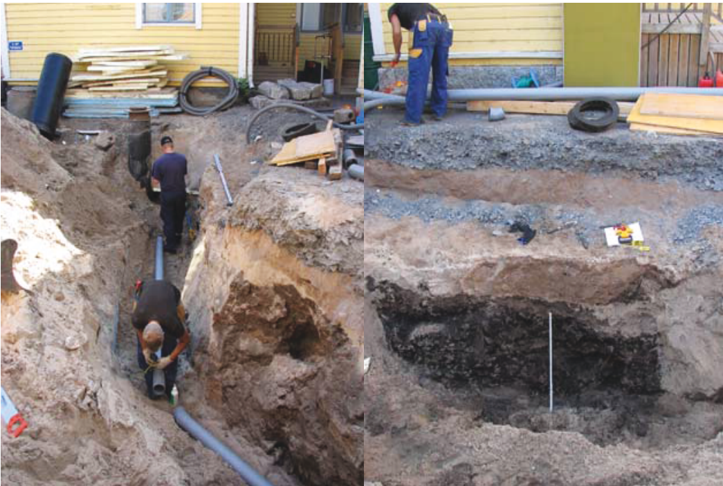
Kuvat 5 ja 6. 3. ja 5. kaivojen välinen kaivanto. Yleiskuva sekä eteläprofiili.
