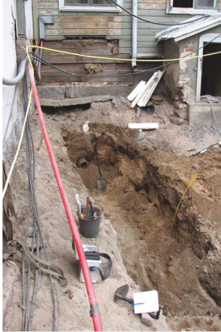
Kuva 10. 3. kaivon länsikaivannon yleiskuva.
