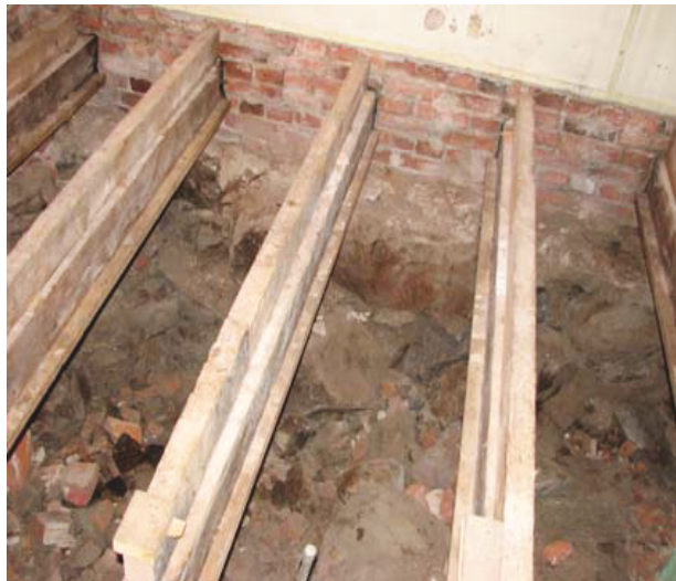
Kuva 33. Byströmin läntisen kivitalon lattiataason alapuolella ollut kivitaso.
