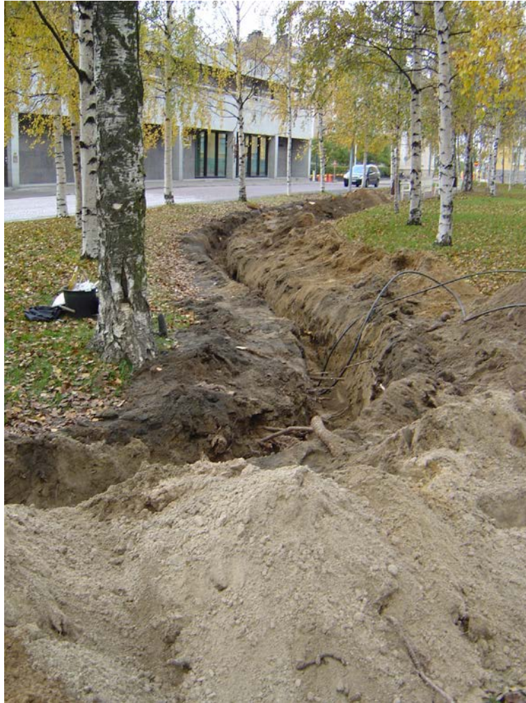
Kuva 20. Yleiskuva 1. kaapelikaivannosta Franzenin puiston etelälaidalla.
