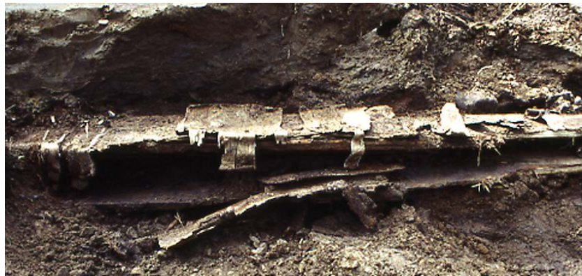
Kuva 16. Tuohella päällystetty viemärirakenne.
