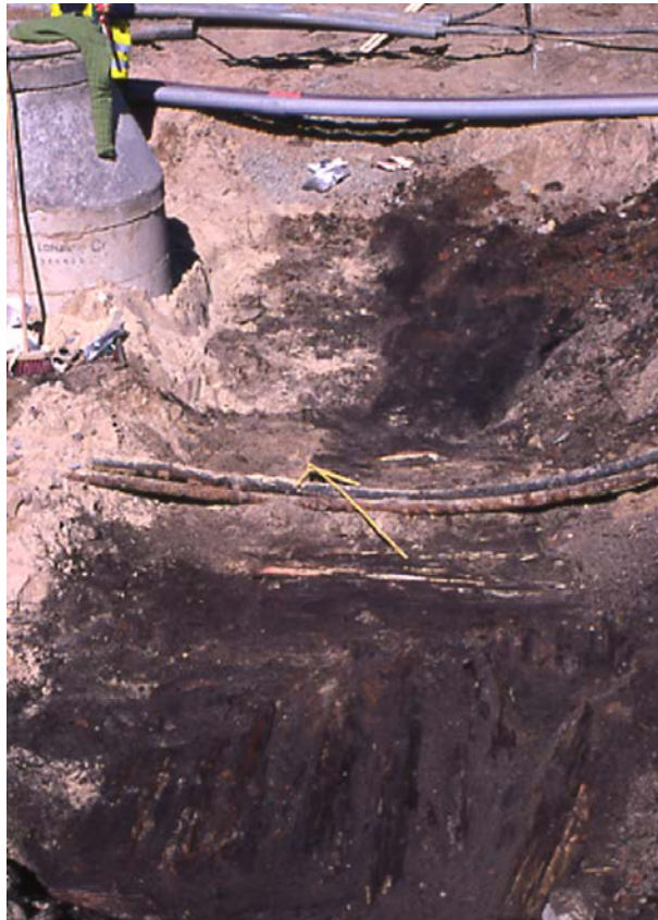
Kuva 14. R32 osa B. Katusiltarakenteen puita kahdessa kerrassa.
