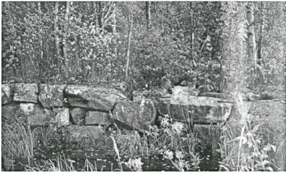
Möljän kylmämuurattua kivimuuria.
