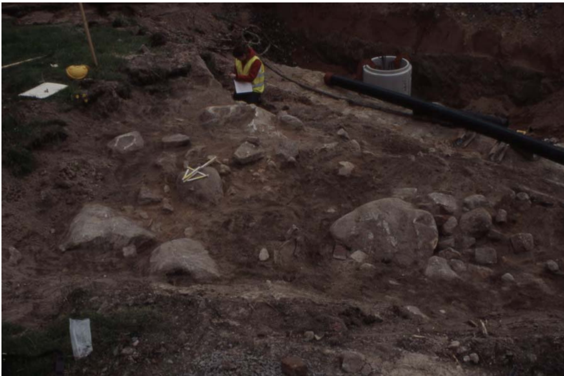
Kuva 19 Työkuva. R11/12 peruskiviä tasossa 1 (ylin taso). Dia 125657:58, MV/RHOA. Kuvaaja: Tiia Ikonen.
