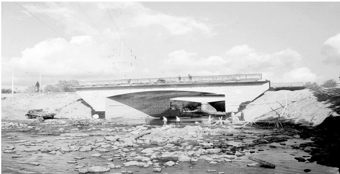
Kuva 1. Pokkisen uutta siltaa rakennetaan 15.9.1958. Lähde: PPM, Uuno Laukan kuvakokoelma, kuva nro. 1773.
