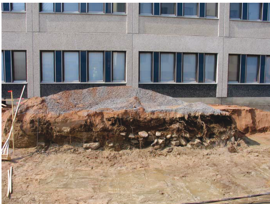
Kuva 1. Kivijalka (R1) Valtion virastotalon kaakkoissivulla (digitaalikuva 13, TKAK-06). Kuva luoteeseen.
