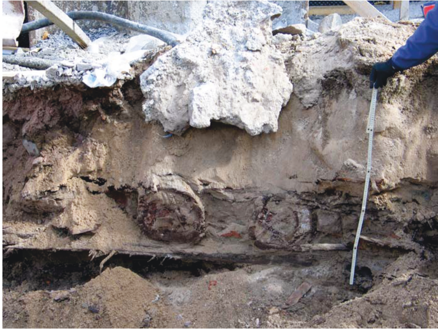
Kuva 6. Pölkkyjen päitä ja lautataso koillisprofiilissa (R11). Perustus. (digitaalikuva 80, TKAK-06).
