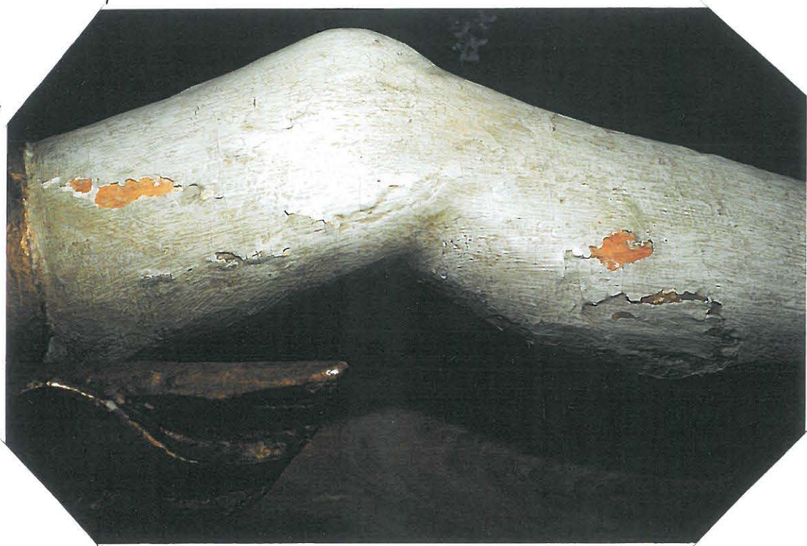
IRRONNEITA JA IRTOAVIA KEBROKSIA
