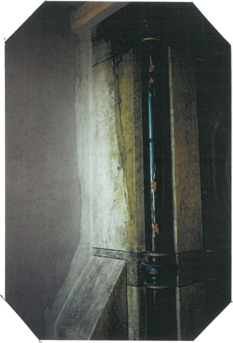
MARMOROINNIN KULUMISTA (HAA- LISTUMISTA) LAITTEEN SIVUOSISSA. PUU-OSISSA PINTAKÄSITTELYN IETOA- MISTA SUURINA LIUSKOINA.
