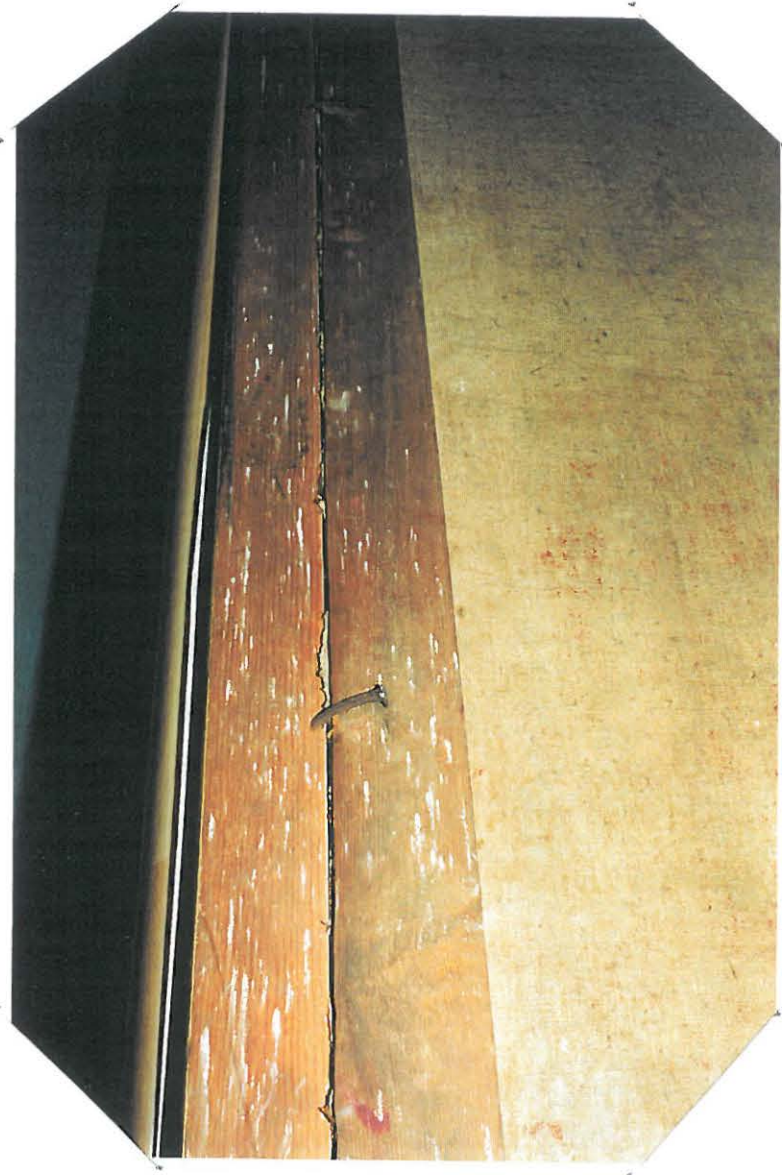
KEHYS KIINNITETTY TALONAU- LOILLA.
