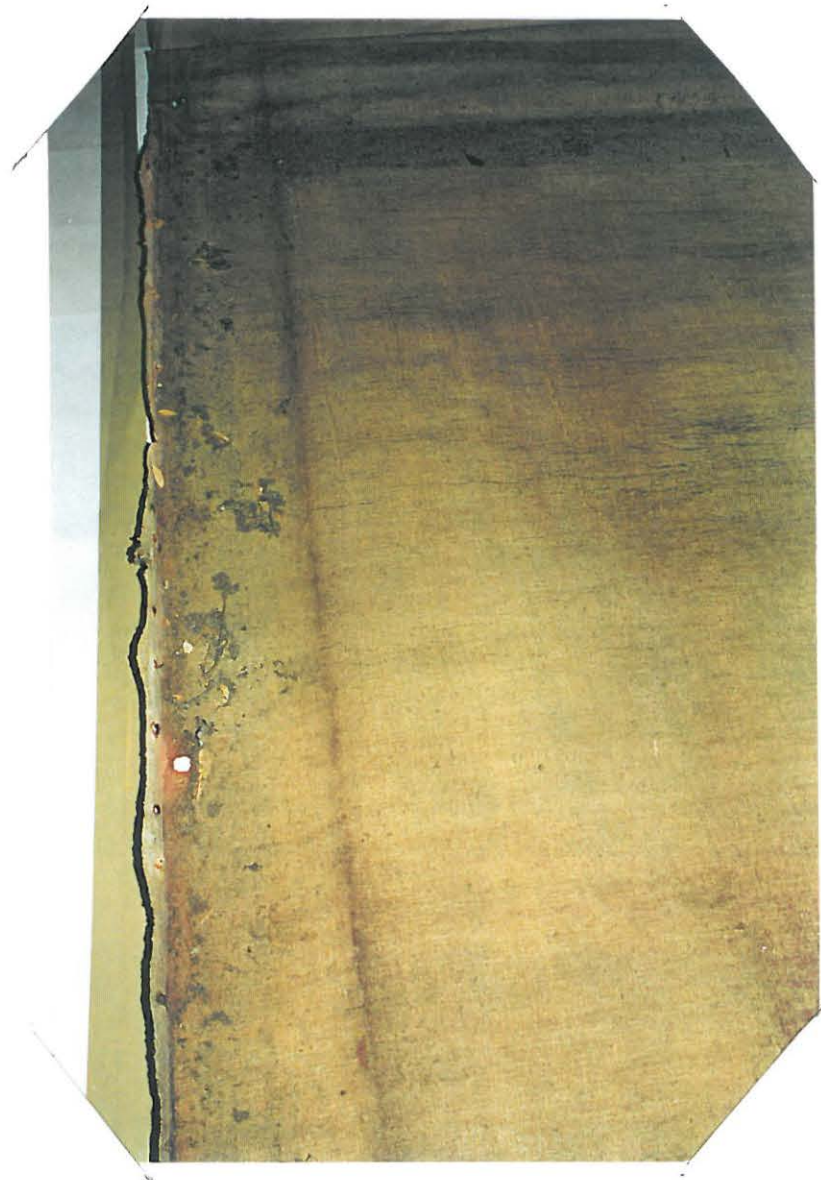
NAUKANKEHYKSEN ALLE KER- TYNYTTÄ LIKAA.
