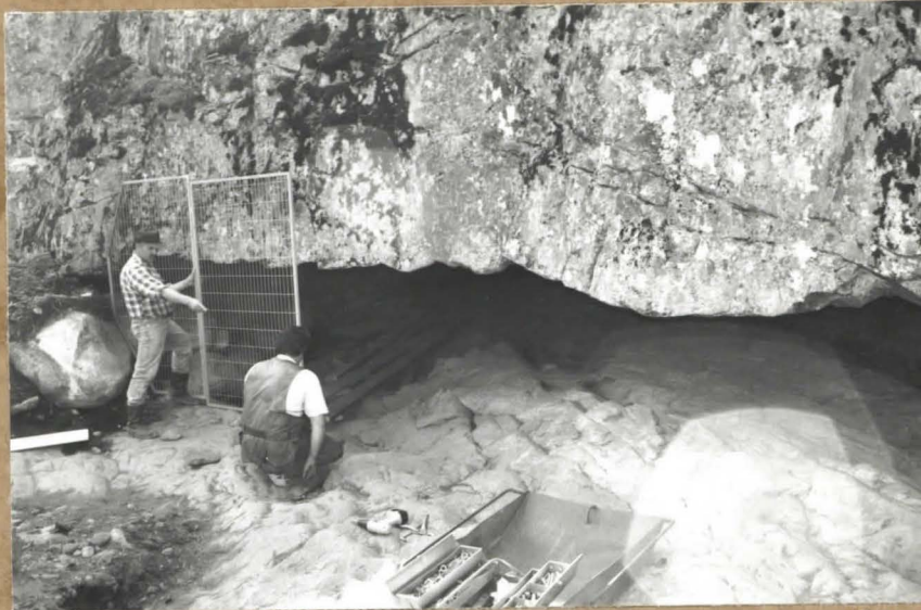
Luolan suuaukko suljetaan teräsverkkoelementeillä. 109311
