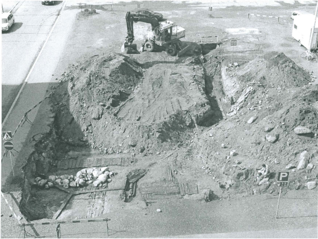
Kuva 3. Yleiskuva kaivausalueesta. Kone täyttää viemärikaivantoa. (Digikamera, kuva n:o 77)
