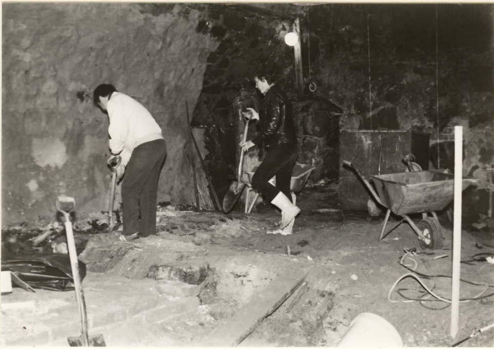
KELLARIN SW-NURKAN PINTAMAATA NEG. 7602
