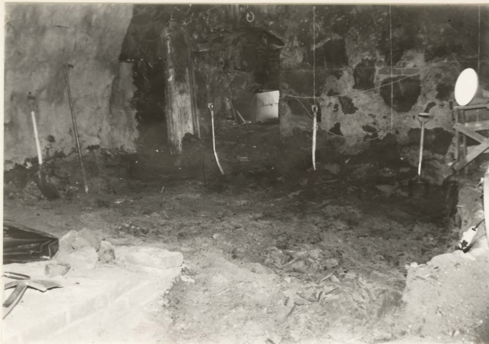
KELLARIN ETELÄSEKTORIN PINTAMA JA TÄYTEHIEKKA POISTETAAN NEG. 7616
