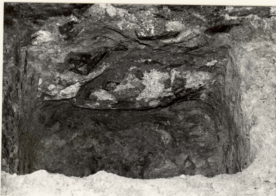
1/ Kellarin S-seinän koekuoppa
