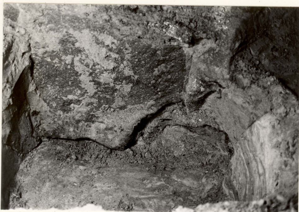
3/ Kellarin N-seinän koekuoppa. Perustuksen ra- ja näkyy oikeas- sa laidassa.
