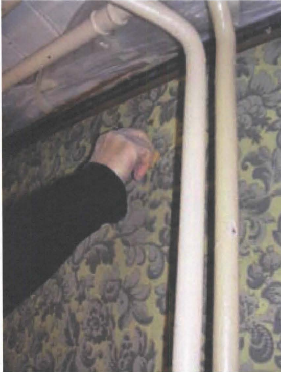
KUVA 7 TAPETTIA PUHDISTETAAN WISHUP-SIENELLÄ.
