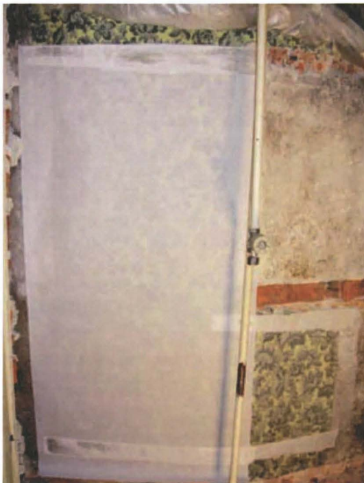
KUVA 10 POHJOISSEINÄN ALAOSAN TAPETTIFRAGMENTIN SUOJAUS JAPANINPAPERILLA.
