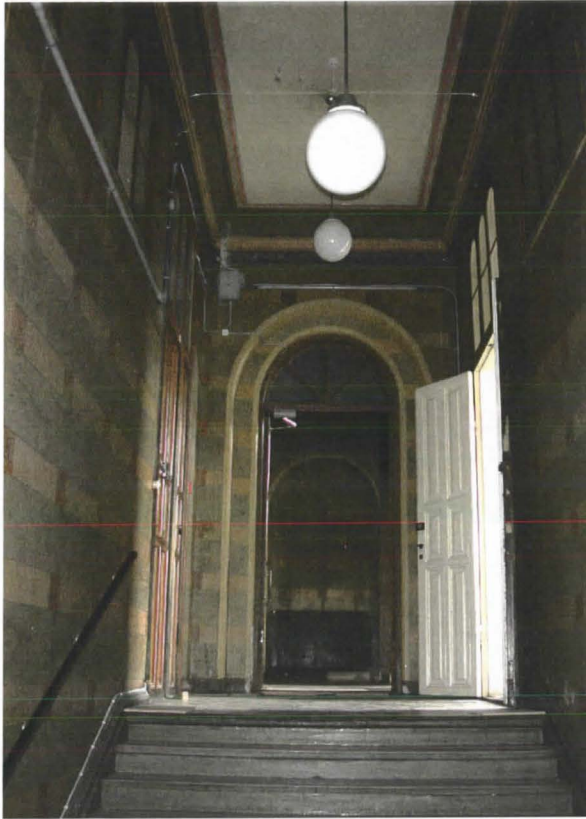
Ovissa peilit pähkinäpuuotratut, kehykset esim. mahonkiootrausta, peilipinnoissa korkeakiiltoinen lakka, peilien profiloinneissa puolikiiltävä. (S. Wuorio)
