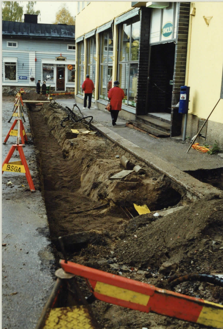
Osittain täytettyä kaivantoa Rihkamakujan pohjoisreunassa. E-W RHO 119359
