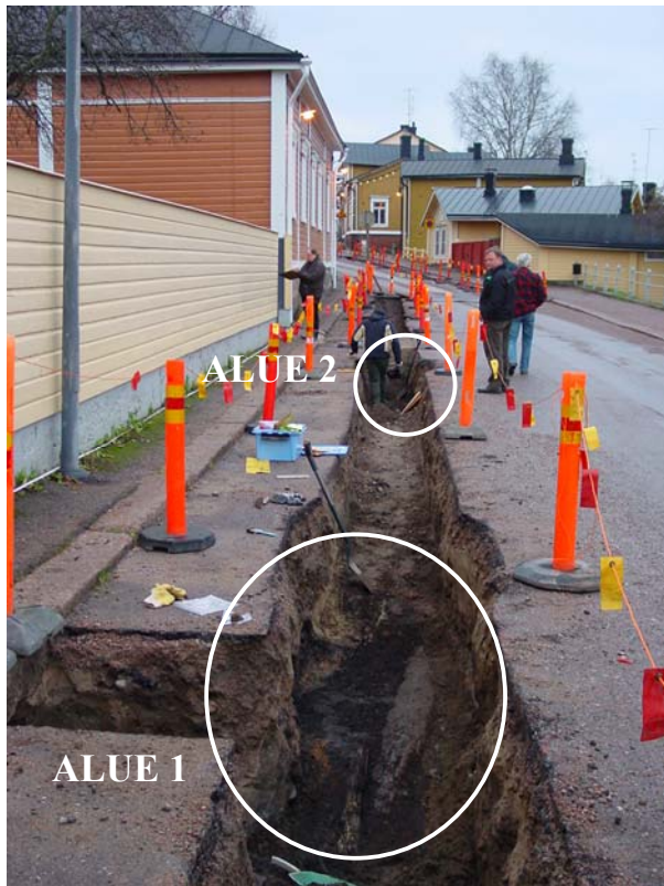
06. Jokikatu 51, yleiskuva kaivannosta.
