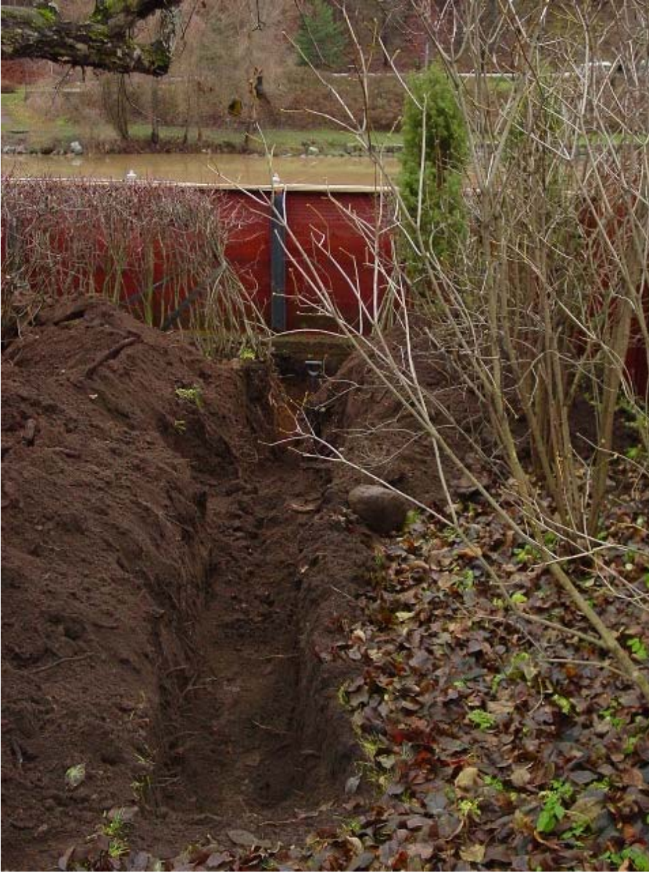
11. Löydötöntä kaivantoa Jokikatu 51:n pihamaalla.
