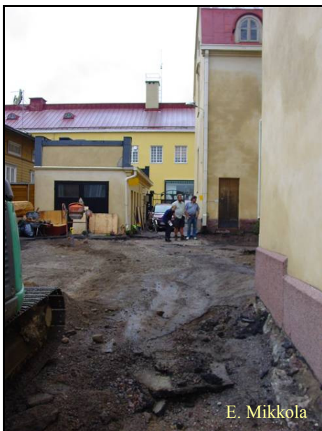
Kuva 1. Itä-Uudenmaan Osuuspankin sisäpihan asfaltin poistoa. Kuvan henkilöiden edessä ylempi nupukivitaso on juuri tullut esille.
