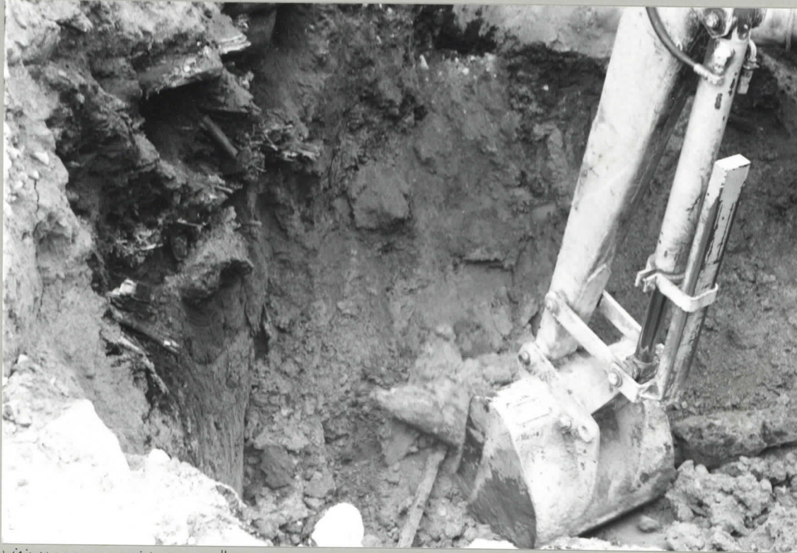
VÄLIKADUN ITÄLAIDAN "KAUKOLÄMPÖKAIVON" MONTUN KAIVAMISTA. KUVATTU LÖUNASTA.
