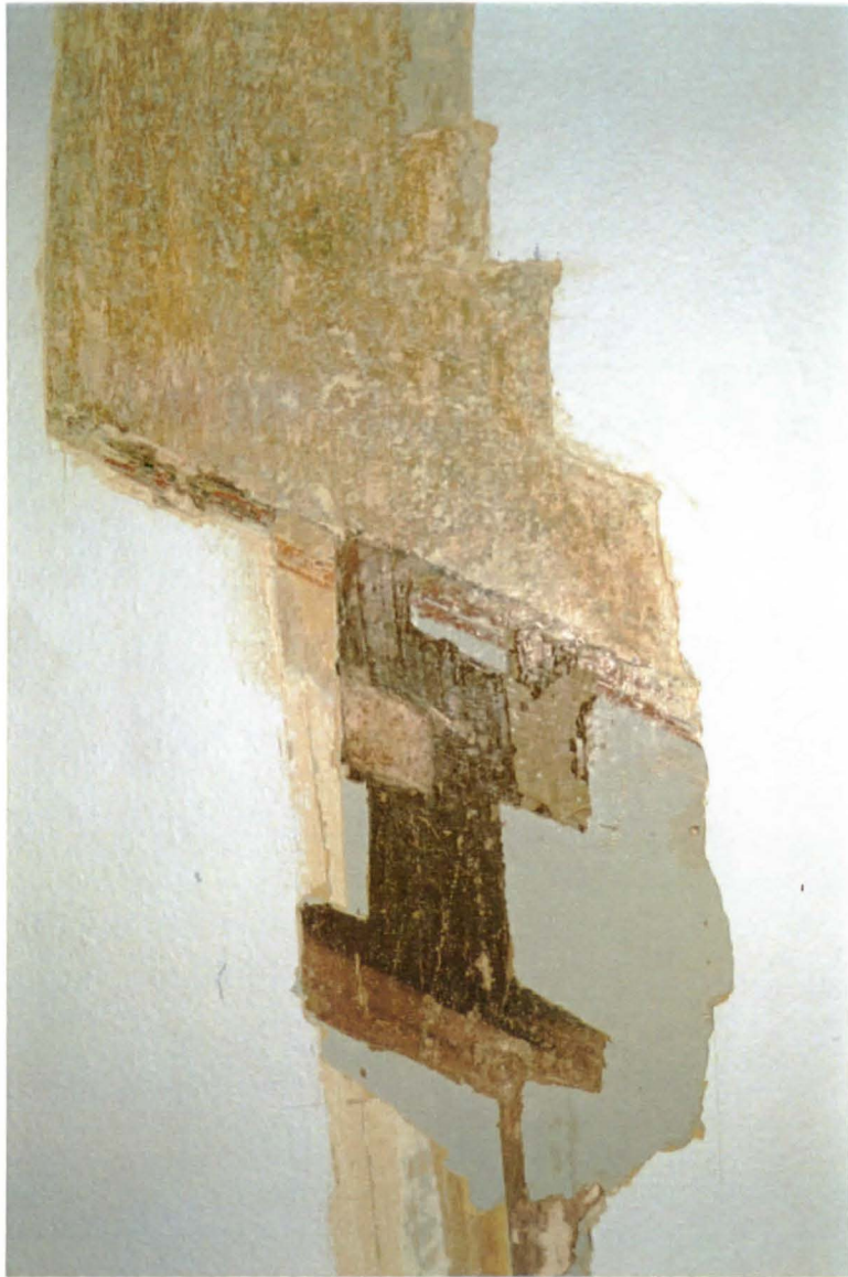
Huone 103 Seinän alaosa
