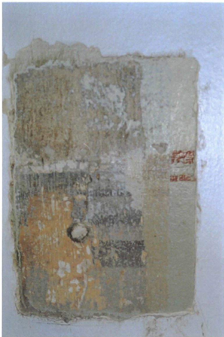
Huone 110 Seinän alaosa
