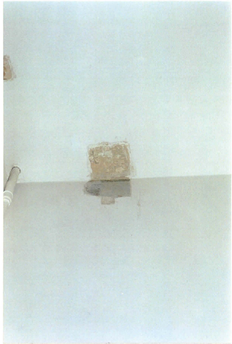
Katto ja seinän yläosa
