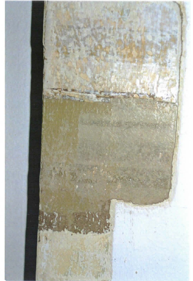
Huone 115 seinän alaosan sabloonakoriste ja myö- hemmät maali kerrokset
