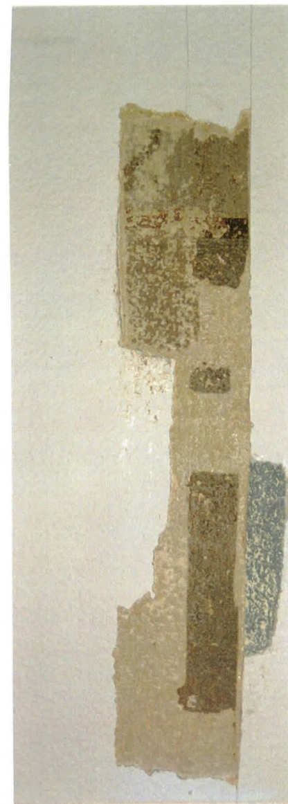
Huone 105 porrasta 103 vasten
