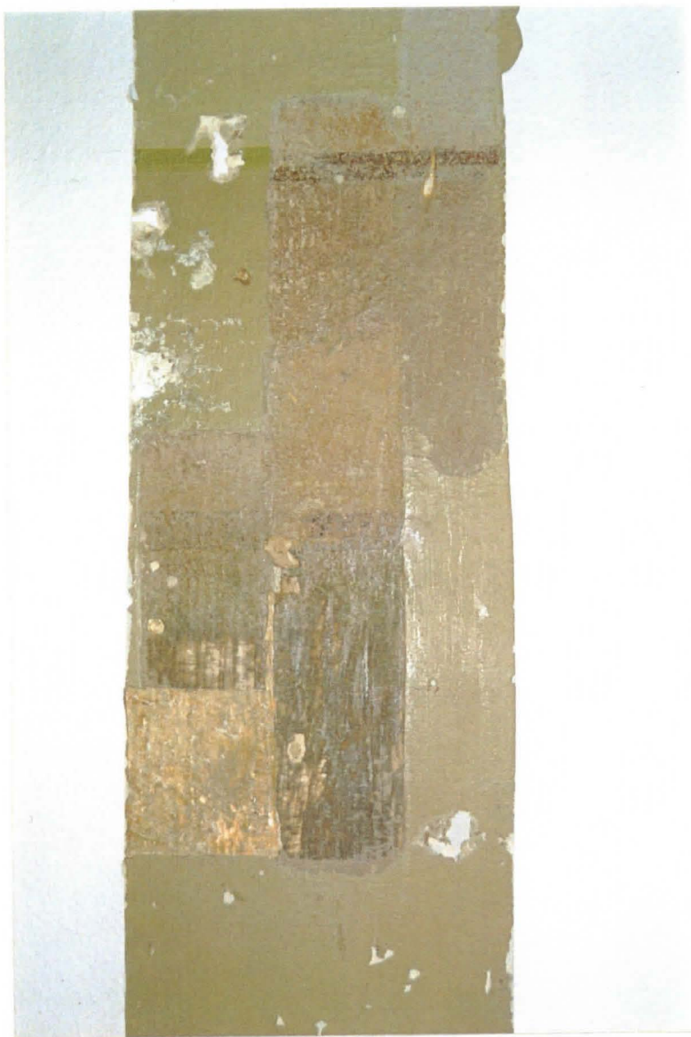
Huone 144 Seinän alaosa
