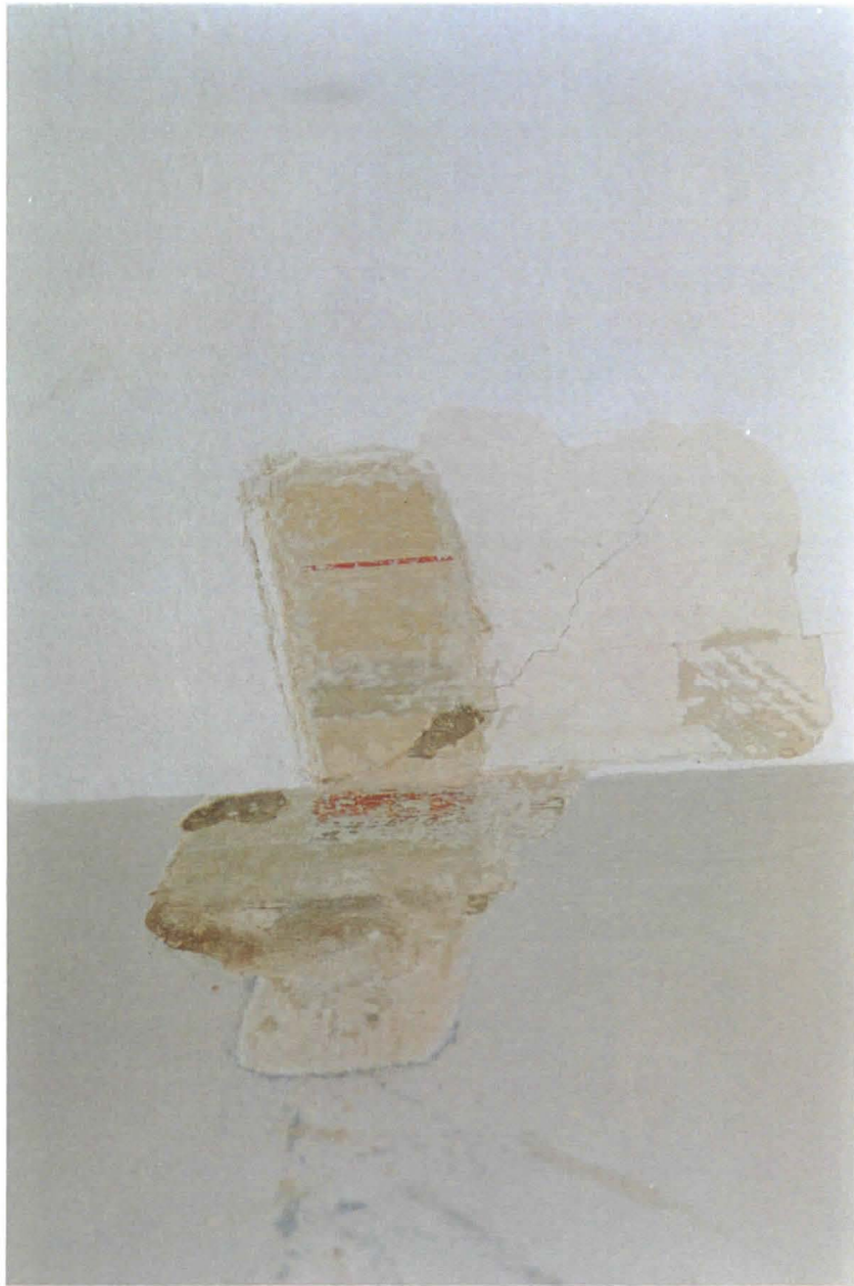
Huone 112 seinän yläosa ja katto
