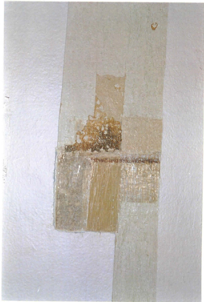
Huone 112 seinän alaosa
