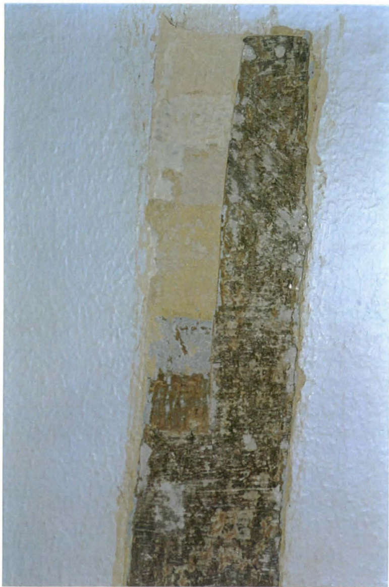
Porrashuone 103 - 303 Seinän alaosa
