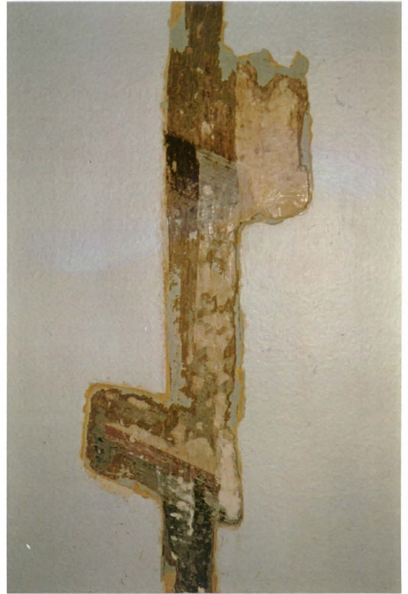
Huone 103 Seinän alaosa
