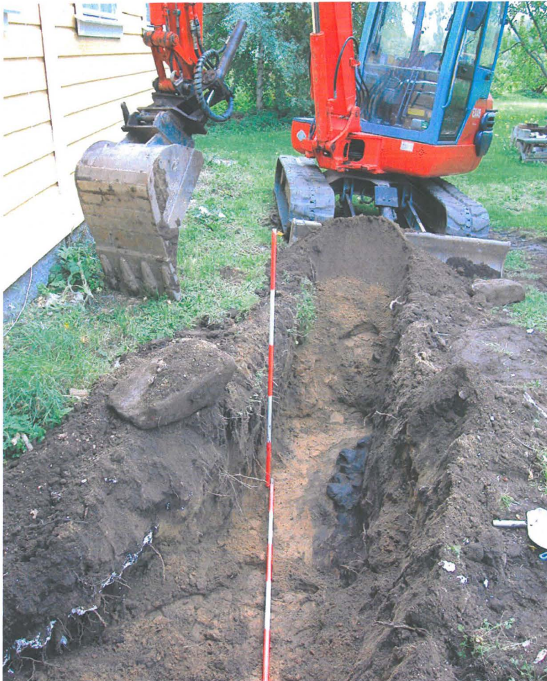
DSCN0001.JPG Tulisija putkikaivannossa.
