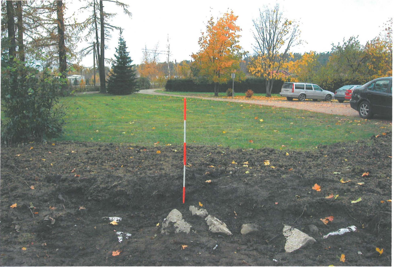
DSCN0043.JPG Perustus 1 osittain peitettynä. Taustalla todennäköisesti rakennuksen paikka.
