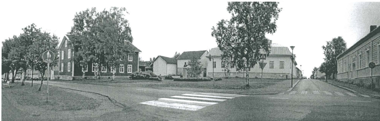
MV/RHOA 124953: 18- 20. Panoraama. Raahen vanha tori, nykyinen Myhrbergin puisto kuvattuna Rantakadun yli. Alkuperäinen torialue jatkui pitemmälle itään kuvassa keskellä näkyvän Heikki Sovion talon pihalle asti. Vasemmalla Soveliuksen 1700-luvun kaksikerroksinen kauppiaantalo. Kohti NE-E.
