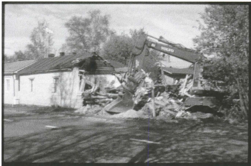
Kuva 1. Purkutyötä. Päärakennuksen eteläpää maan tasalle rouhittuna.
