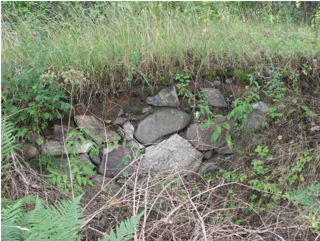
7. Kellarin seinämuurausta. S-N. GH.
