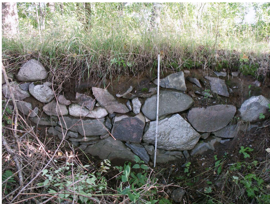
Päärakennuksen kellarinseinämuurausta. Kuva ET.
