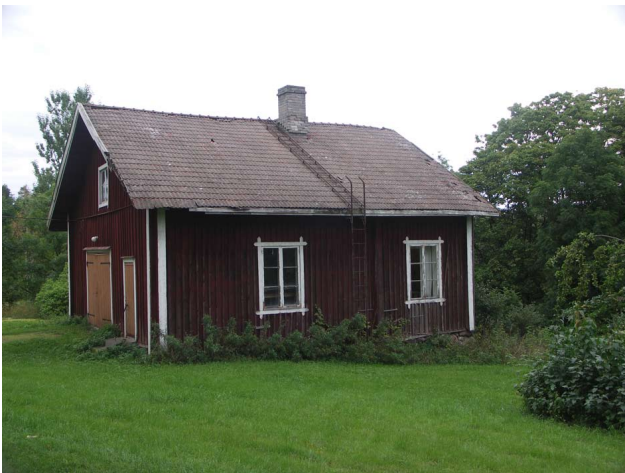
2. Raaseporin kartanon nykyinen ulkorakennus (ennen pohjoinen sivurakennus). SW-NE. GH.
