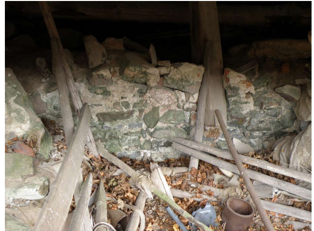
27. Vanhan päärakennuksen kellarin päätyseinä. SW-NE. GH.
