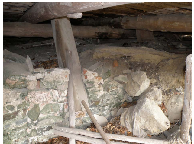
28. Vanhan päärakennuksen kellarin päätyseinä. Huom. hiekka- ja olkipatja. W-E. GH.
