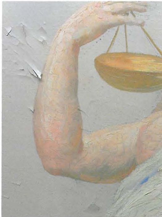
Öljyväli on irronut pohjustuksineen ja roikkuu eri kokoisina kielekkeinä katosta. Esimerkkejä vaurioista kuvakentässä n:o 8.
