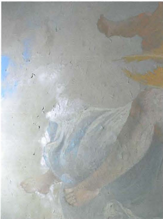
Öljyväli on irronut pohjustuksineen ja roikkuu eri kokoisina kielekkeinä katosta. Esimerkkejä vaurioista kuvakentässä n:o 8.
