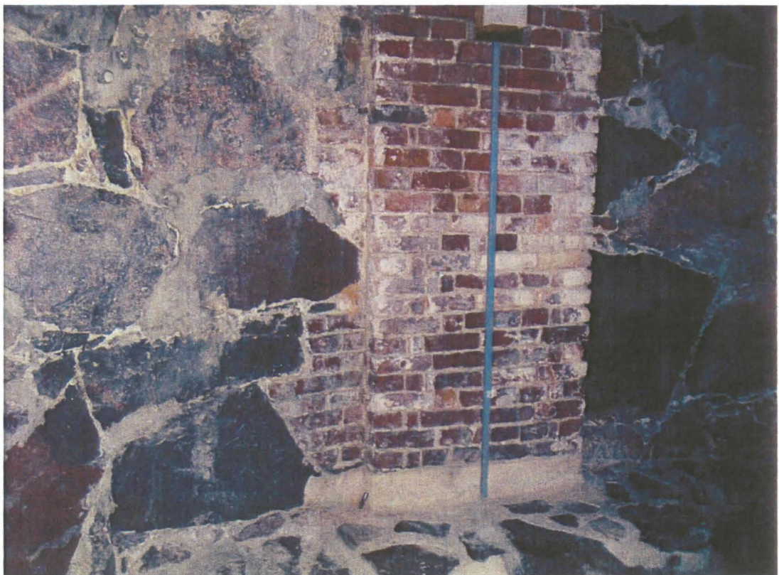
Kuva 4.3 Tiilipilarit ja kiviseinät tukeutuvat kiviperustukseen.
