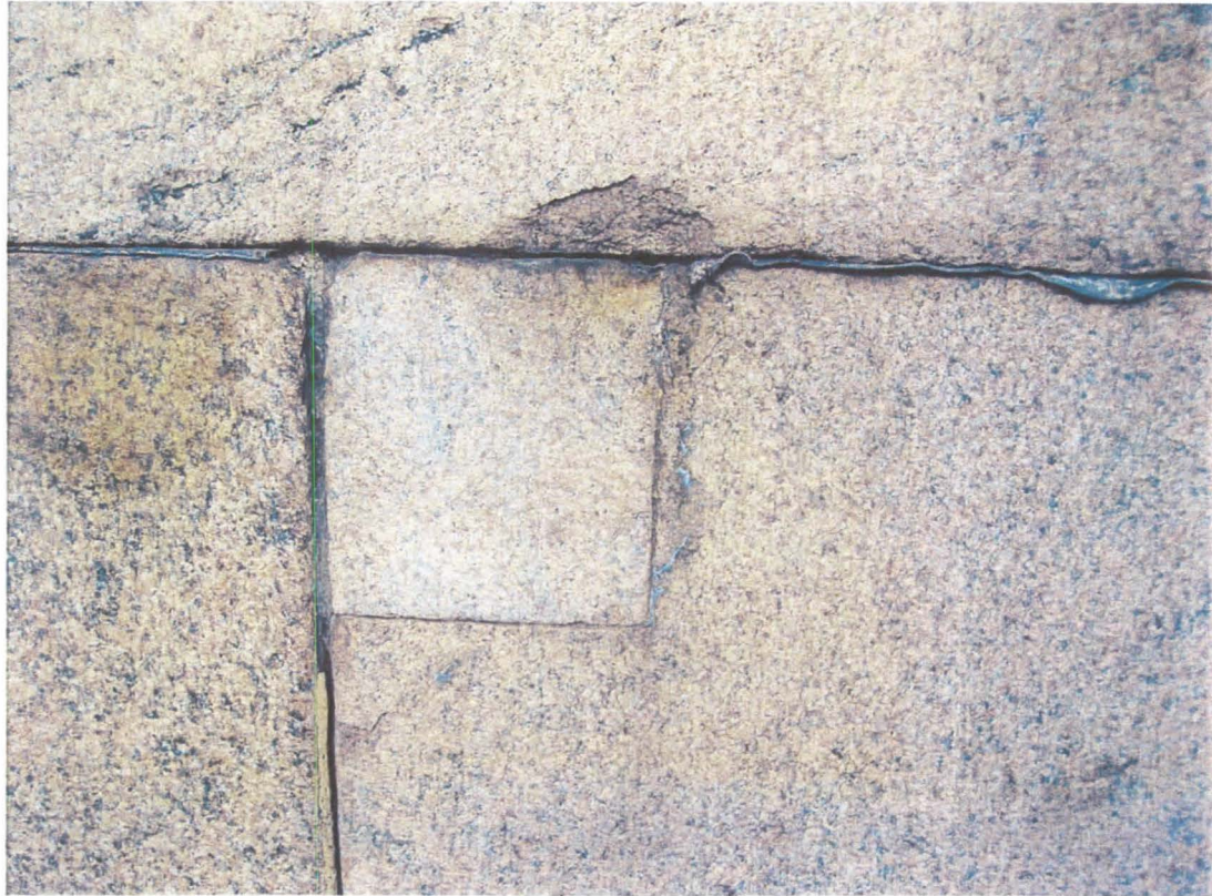
Kuva 2.7 Esimerkki nurkkalohkeaman paikkauksesta.
