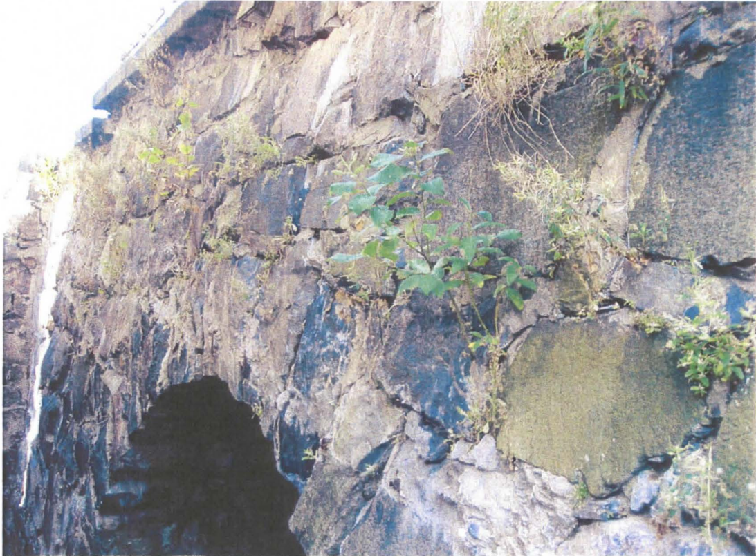
Kuva 2.6 Muurin laastisaumat ovat pitkälle rapautuneita ja niissä kasvaa runsaasti kasvillisuutta. Muurin kivien muoto ja koko vaihtelevat huomattavasti, kaaret on tehty holvaamalla.
