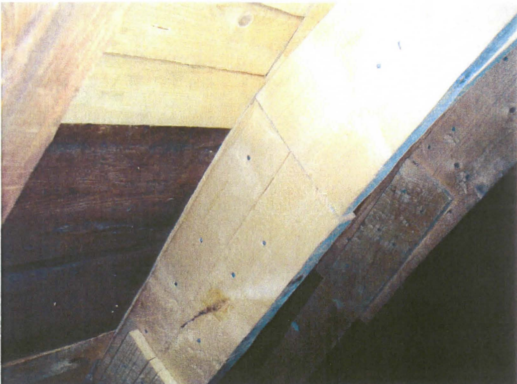
Kuva 6.3 Keskikupolissa puuosia oli paikattu myös pääkannakkeiden osalla
