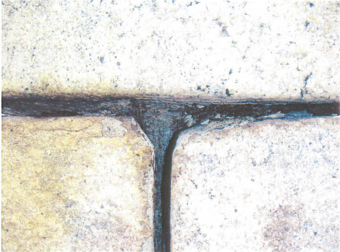
Kuva 2.4 Saumalaasti on rapautunutta ja sen pintaosa on 10 – 20 mm syvyydeltä pudonnut pois.
