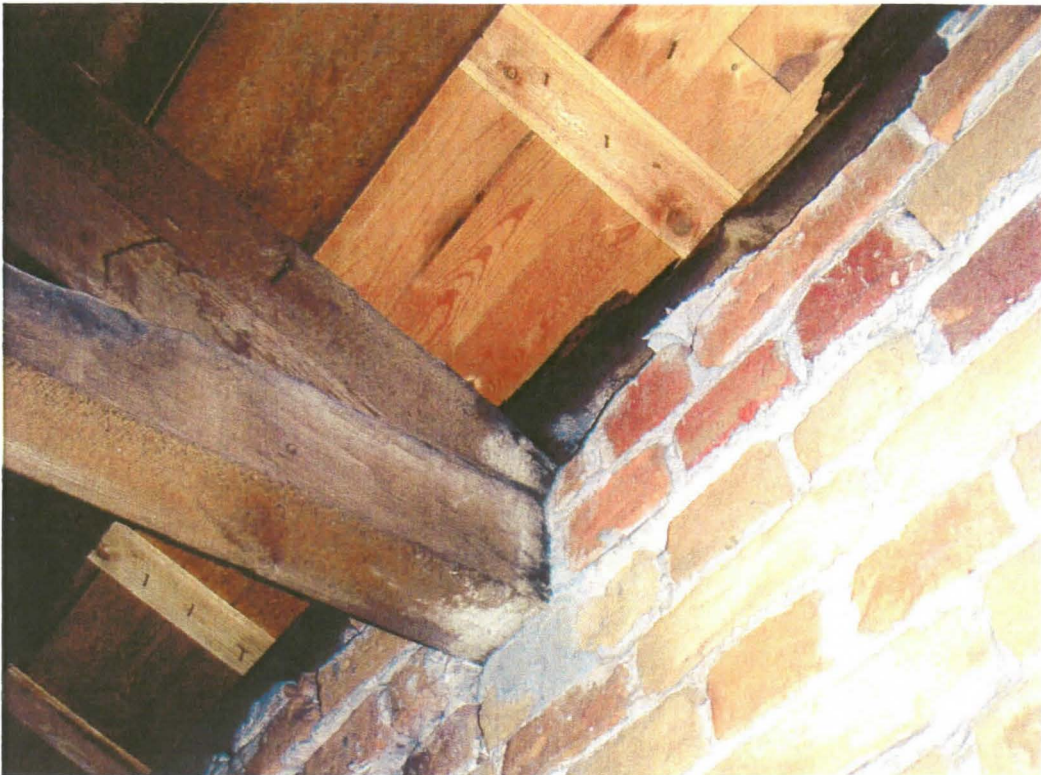
Kuva 6.2 Vesikatteen alle on rakennettu paikoitellen uusi umpilaudoituus vanhan ruodelaudoituksen yläpuolelle
