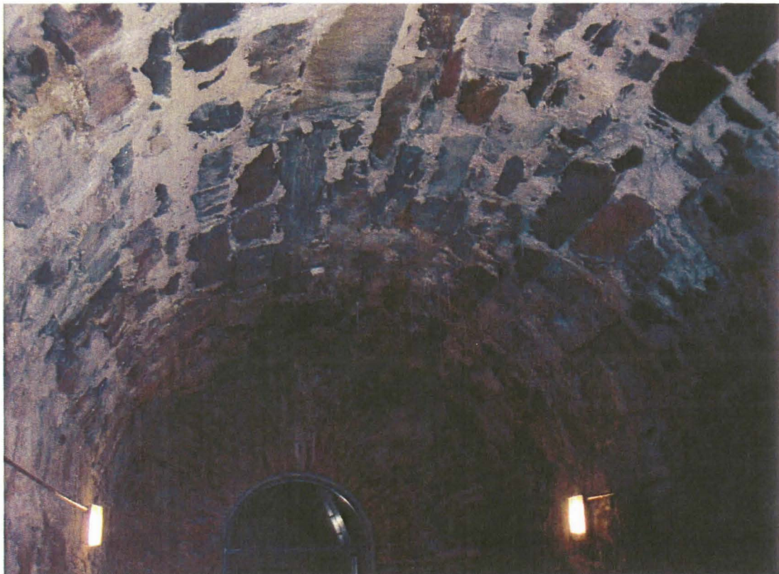
Kuva 4.7 Sakastin takahuoneen katon tippukivimäisiä valumia.
