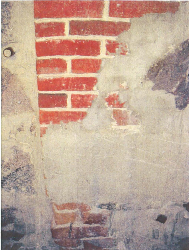
Kuva 4.6 Tiilipilarien rappauskorjauksia.
