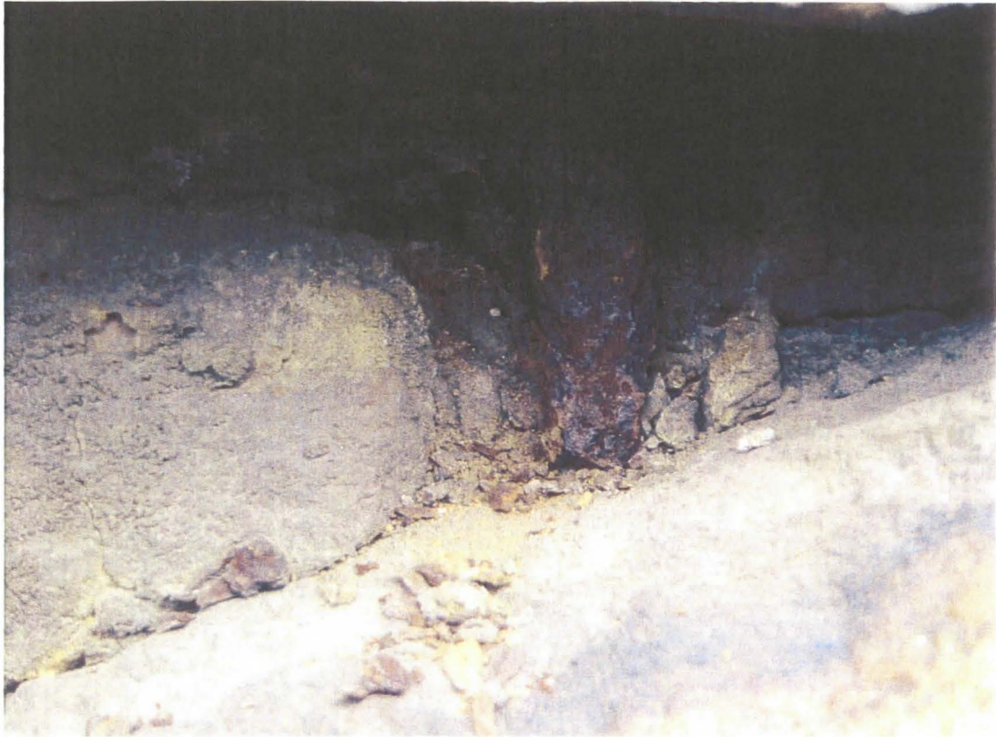
Kuva 2.2 Ruostuessaan metallihakojen tilavuus on kasvanut. Tästä aiheutunut paine on murtanut kivien nurkista paloja irti.
