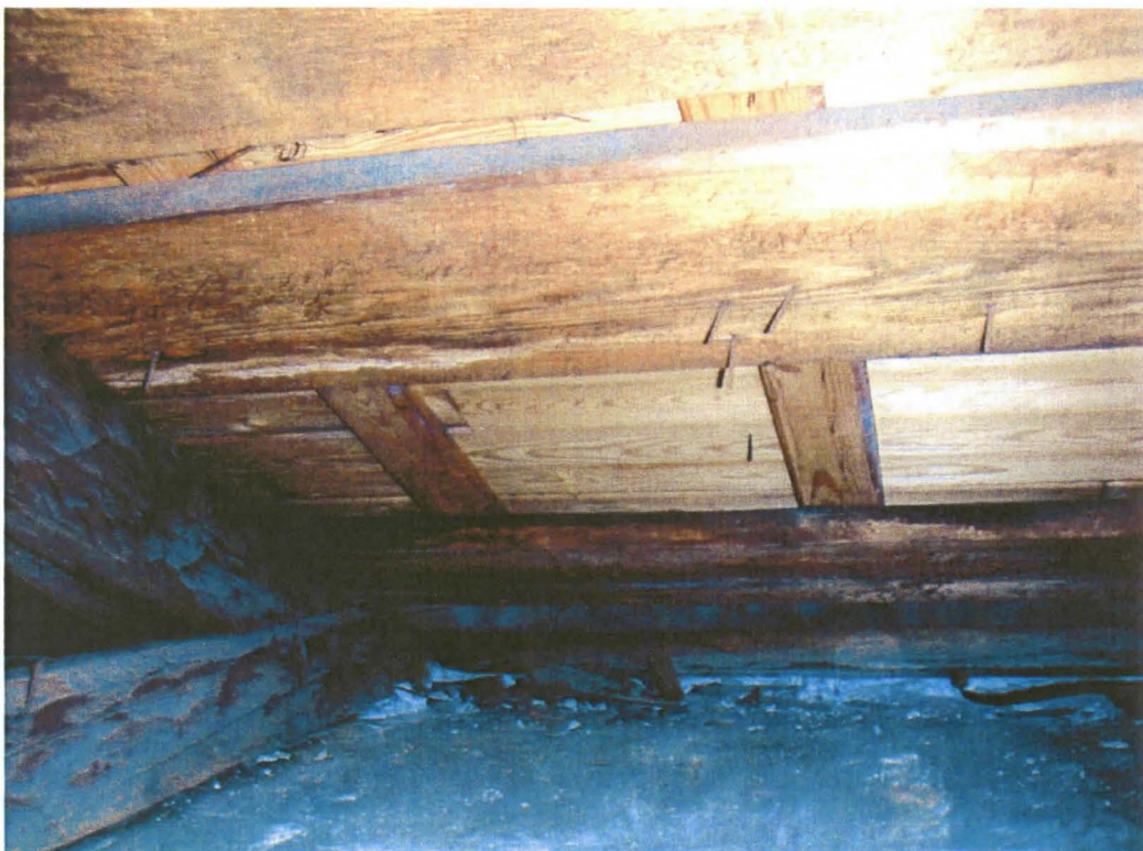
Kuva 6.9 Vesikatteen alle on rakennettu uusi umpilaudoitus vanhan ruodelaudoituksen yläpuolelle
