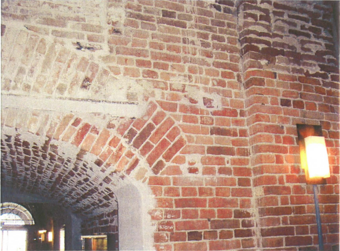
Kuva 4.2 Kryptan seinät ovat pääasiassa massiivitiilirakenteita.
