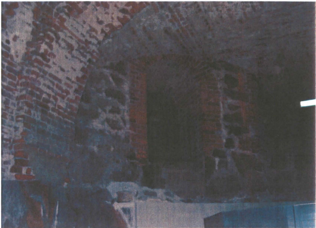
Kuva 4.1 Krypta muodostuu useasta tiiliholvatusta salista.
