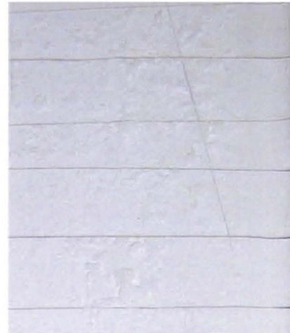
Oven maalipinta on liituuntunut (3)
