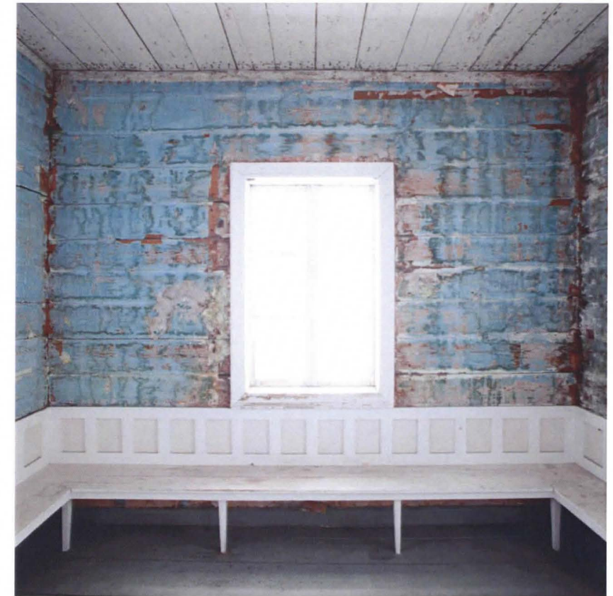
Eteläseinä levytysten poistamisen jälkeen
