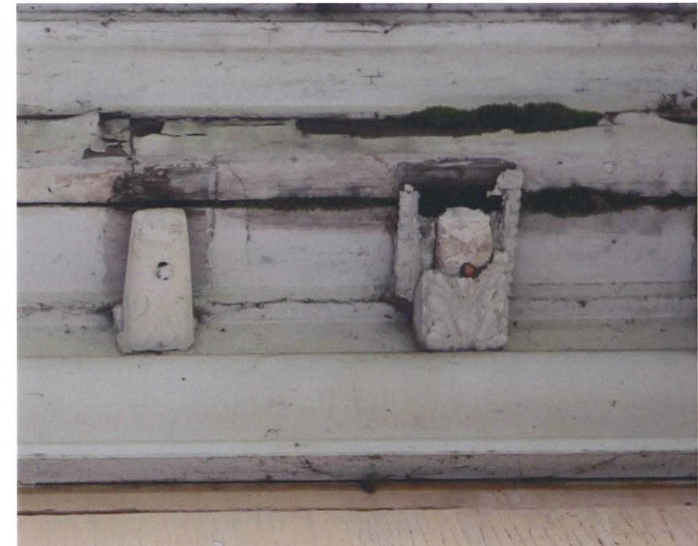
Vanhat kipsikoristeet ovat kuorirakenteisia
