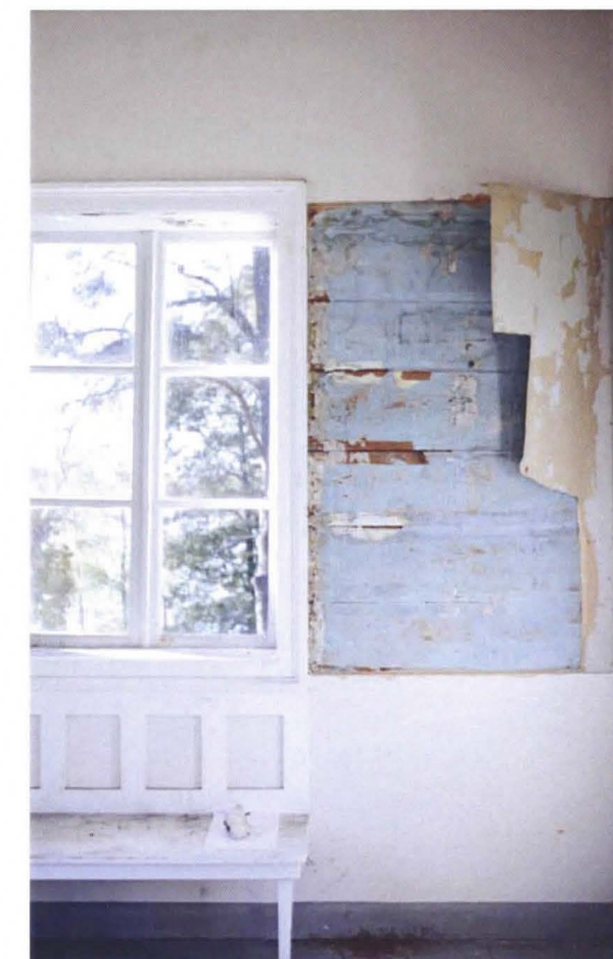
Seinään 2009 tehty avaus
