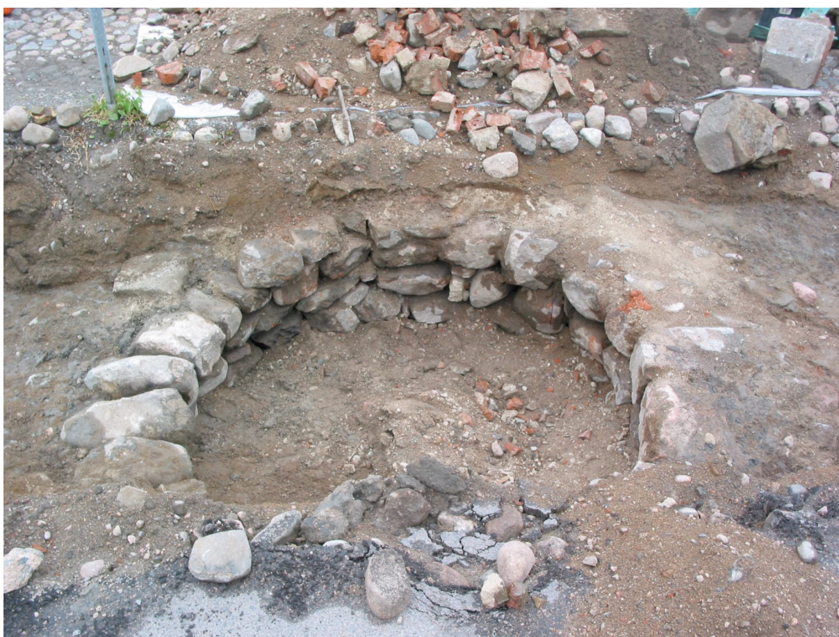
Kuva 3. Kalatorin kaivo on rakennettu lohkomattomista luonnonkivistä. Kahdeksankulmaisen kaivohuoneen purkumassa täyttää kaivon sisustaa. Kuvan yläkulmassa on kaksi kaivohuoneen kulmakivistä. Kuva: Markus Kivistö
