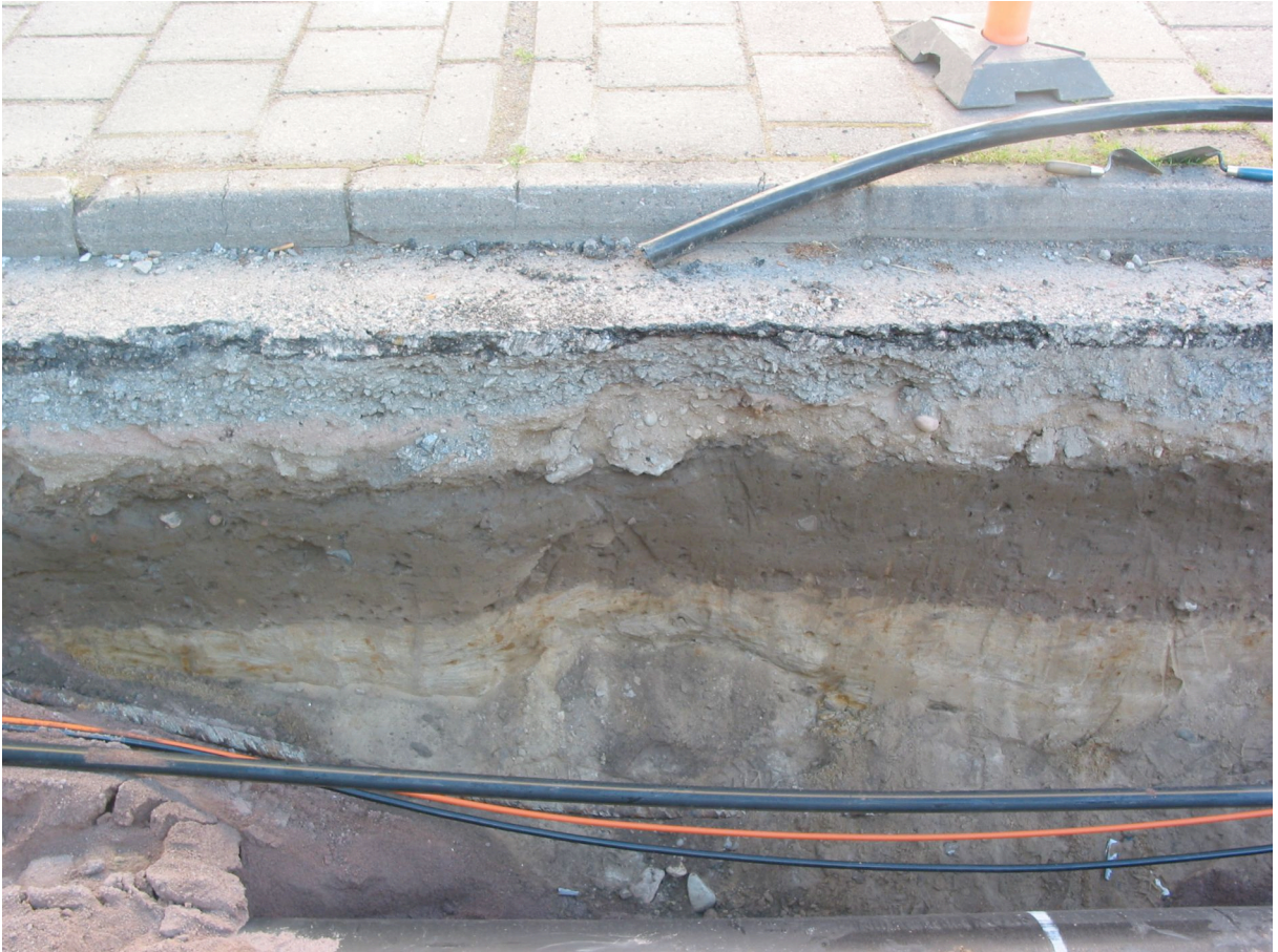
Kuva 5. Alue 6, Kulmalankatu. Vahva 'peltokerros' pohjahiekan päällä. Kadun perustuskerrokset on levitetty suoraan pellon päälle. Vuoden 1773 kartassa paikalle on merkitty pappilan omistuksessa ollut pelto. Kuva: Markus Kivistö
