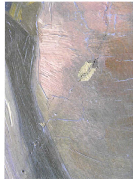
4. Pieniä alueita maalia on irronnut kokonaan niin että rappaus on paljastunut. Esimerkki kuvakentästä 12
