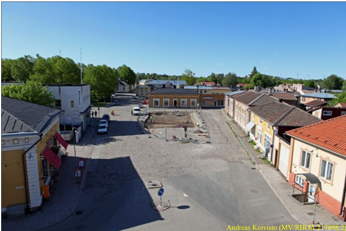
Kuva 1. Kalatori vuoden 2009 kaivausten aikaan.
