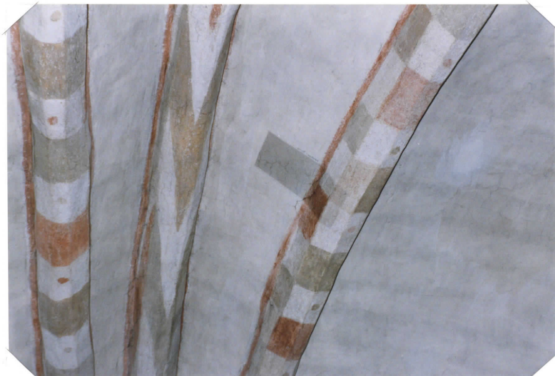
KONSERV. PINTA Puhdistusfragmentti jätetty HOLVISTO NO. 8 S
