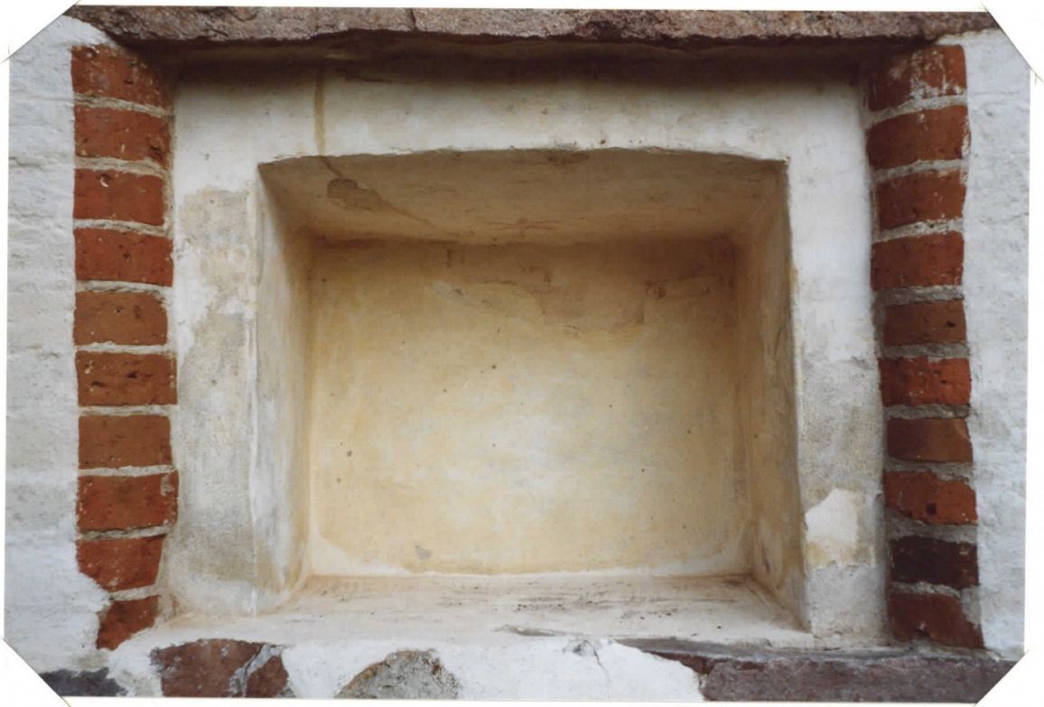
ET. SEINÄN ULKOARSTARI ENNE KONSERV.
