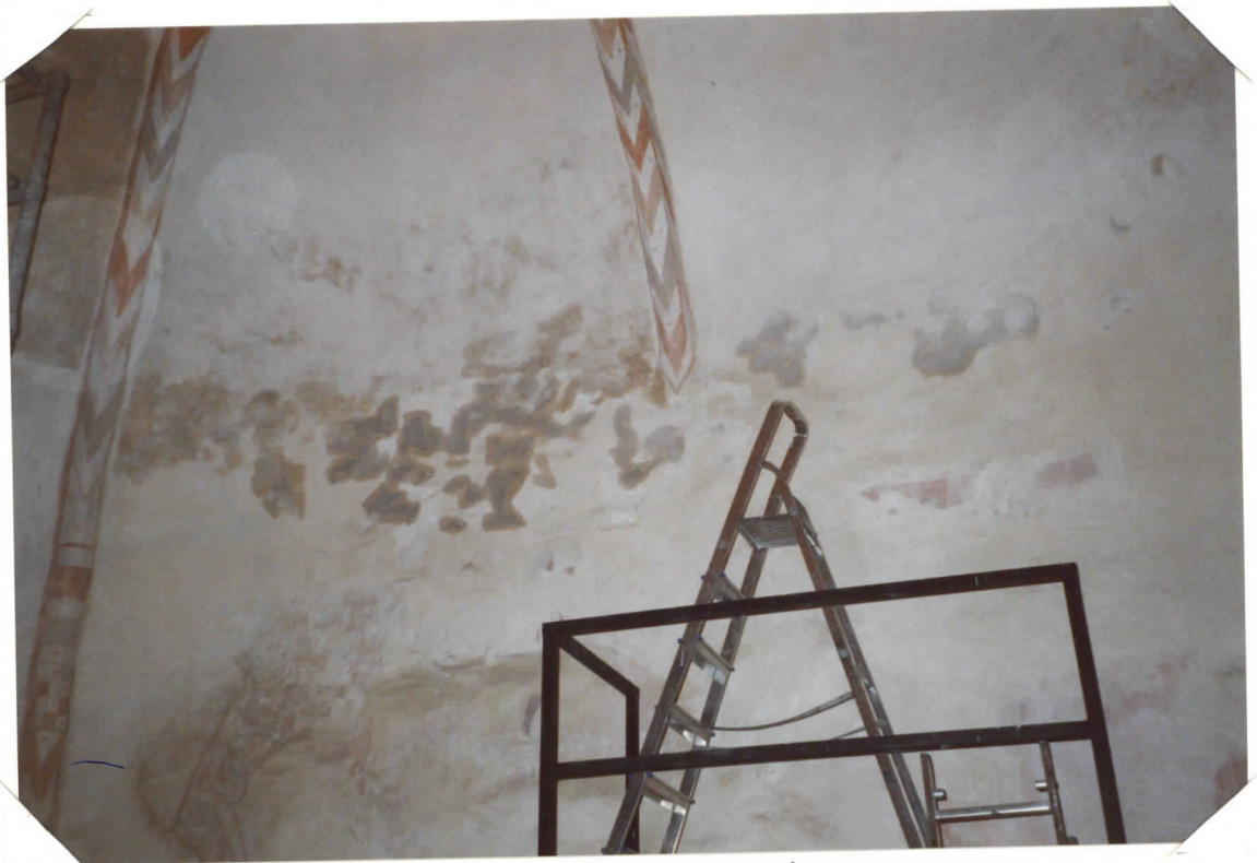
ASEHUONEEN LÄNSISEINÄN MURKUN PINNAN SIDONTA
