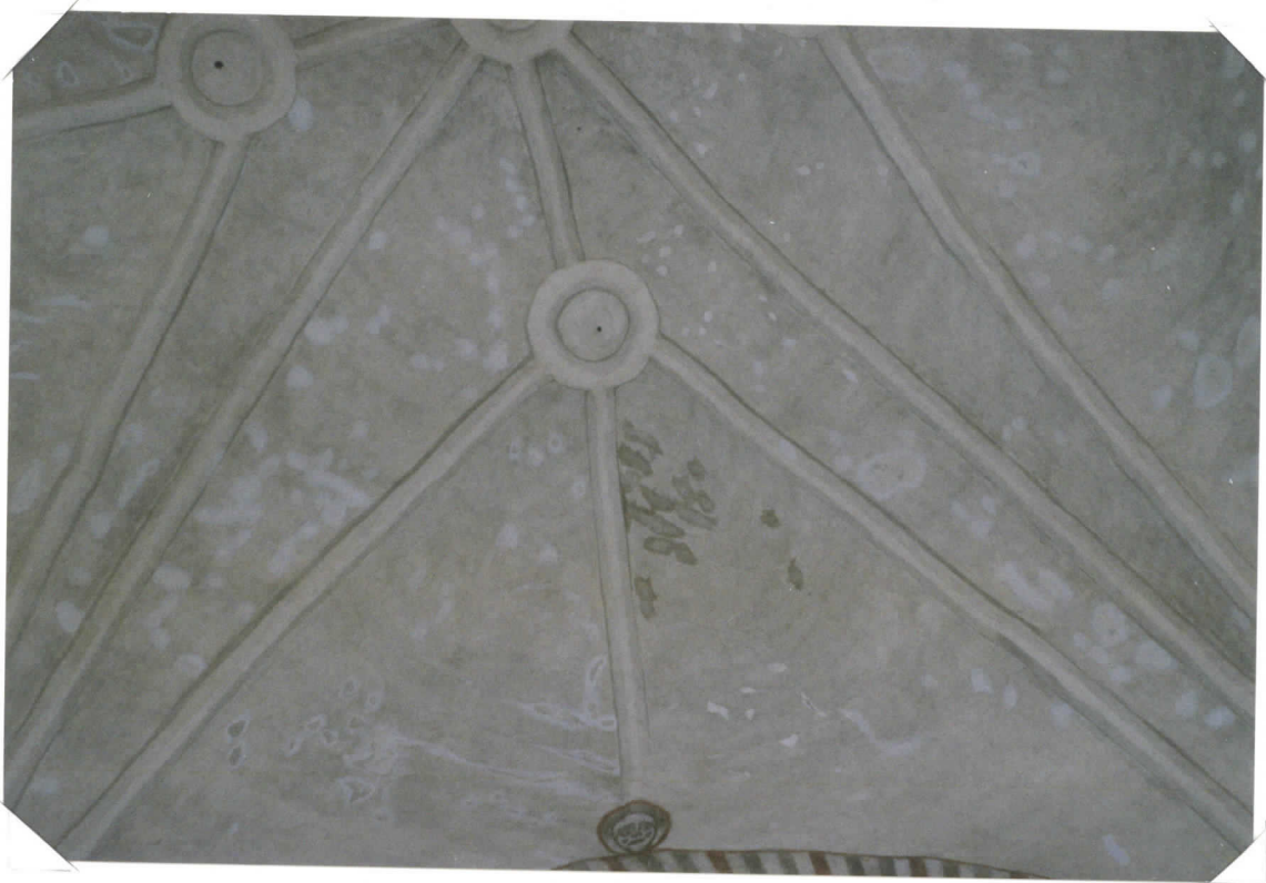
YLÄ OSAA PUHDISTETTUNA JA PAIKATTUNA HOLVISTO NO. 4
