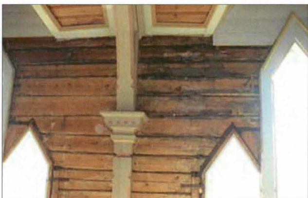
Pohjoissivun B- ja C-lohkojen välissä ei ollut suuria vaurioita.
