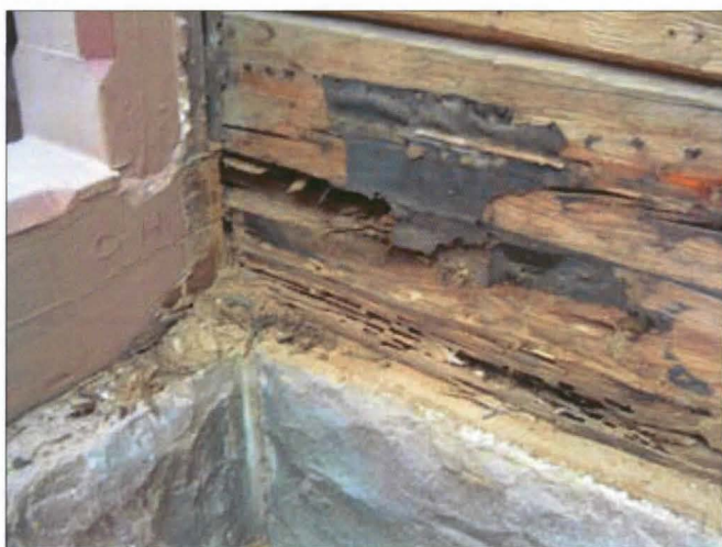
Kaakkoiseteisen ulkoseinän alaosassa laho- ja hyönteisvaurioita.
