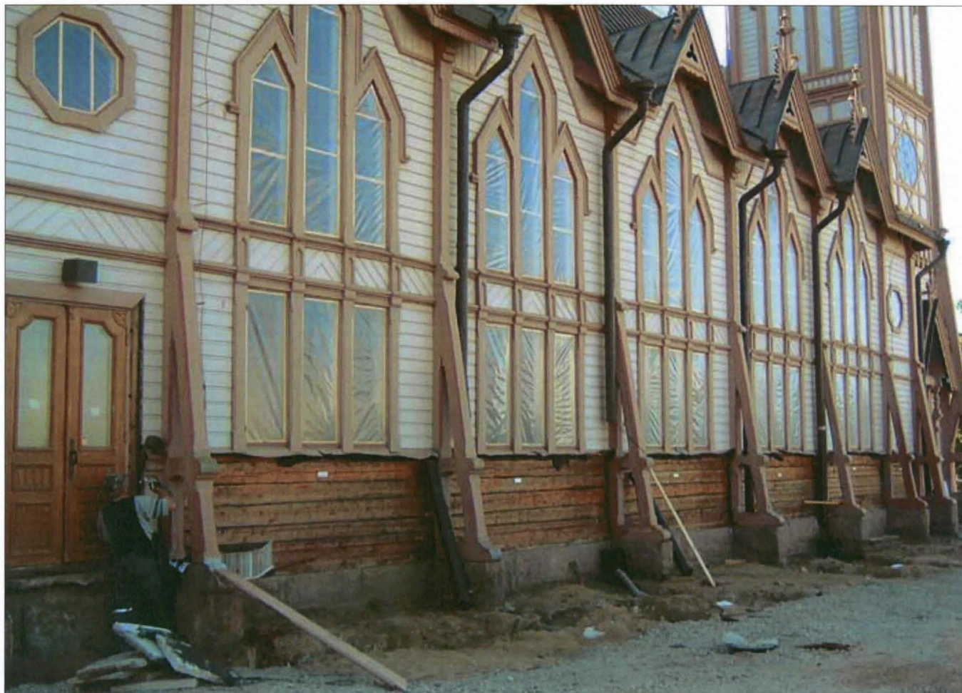
Alaosan verhous pohjoissivulla purettiin rakenteen tarkastamista ja korjausta varten.
