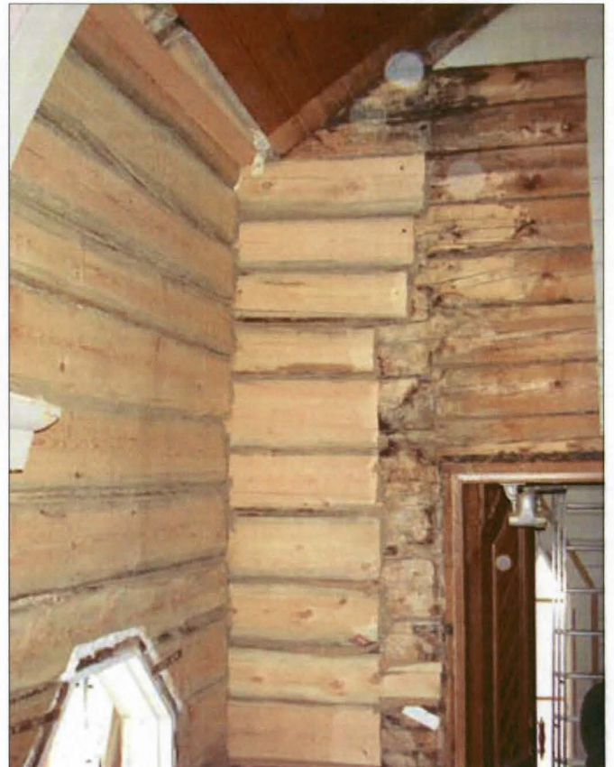
Vinokulmainen liitos oven pielessä. Vanhaan seinään kiinnitettiin kararima. Lisäksi osa uusista hirsistä pujotettiin vanhan salvoksen sisässä olevaan lukkoliitokseen ja kiilattiin puukappaleella yhteen.
