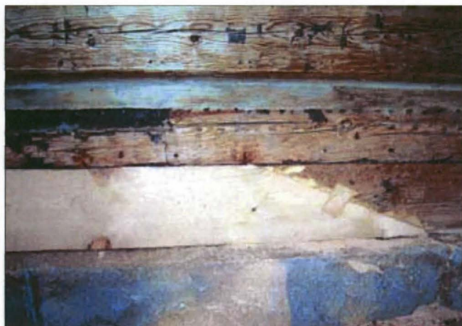
Tuulikaapin osuudelta aluspelkka jouduttiin uusimaan. Vanhan ja uuden jatkos tehtiin entisenkaltaisella lukkoliitoksella. (Kuvat alla)
