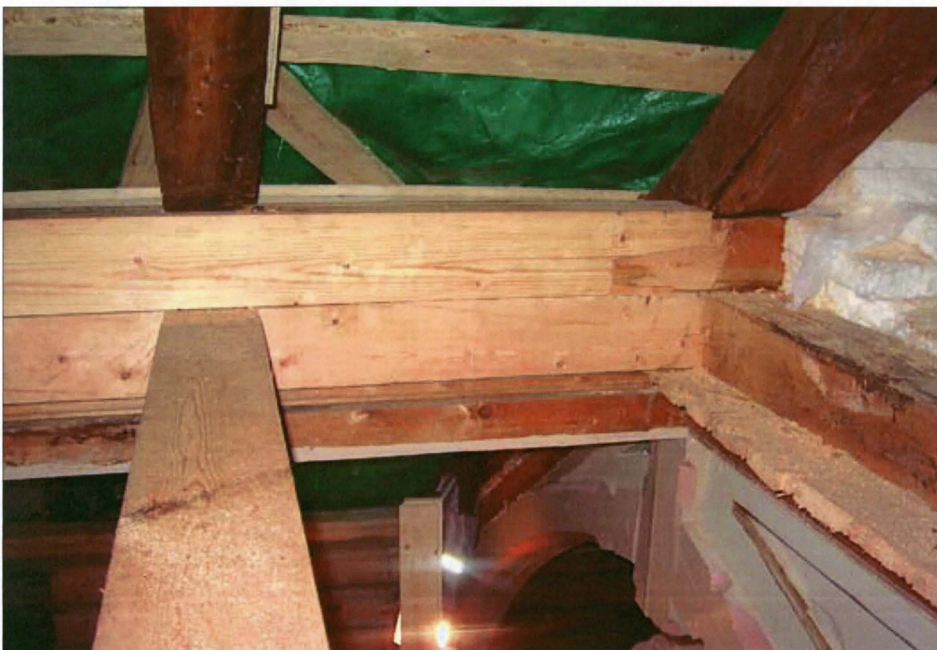
Kuvissa vesikaton uusitun pitkittäisen palkin liitos torniin ja kehärakenteen päälle.
