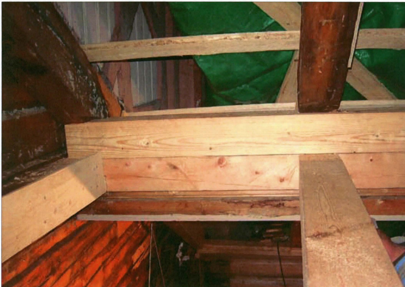
Kuvissa vesikaton uusitun pitkittäisen palkin liitos torniin ja kehärakenteen päälle.
