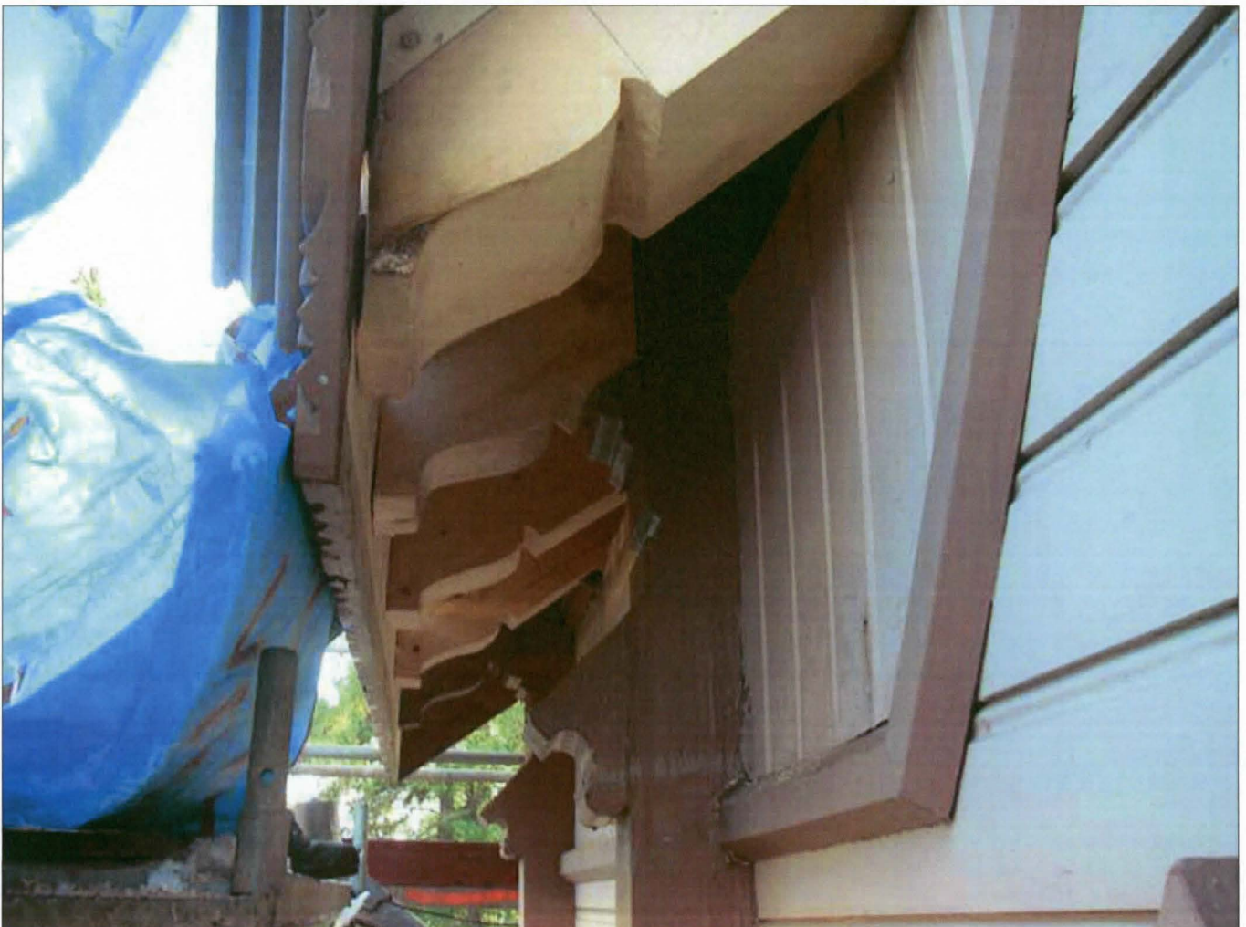
Uusitut kattotuolin päät maalataan ulkomaalauksen yhteydessä.
