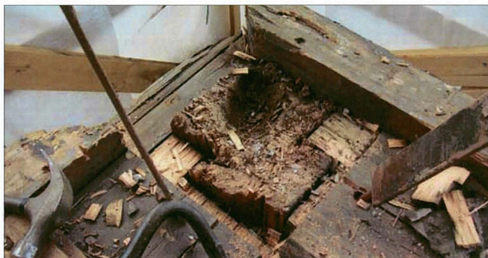
Korjaustyön aluksi eteläkulman pilarin alta piti etsiä kovaa puuta. Pileri oli edellisen kerran korjattu Plastic Padding -massalla.
