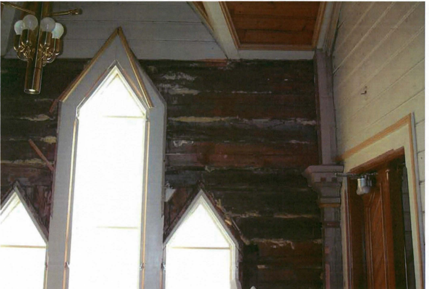
Yläkuvassa lohkojen D ja E väli. Alakuvassa lohko F. Kuvat on otettu ennen seinien tilkitsemistä.
