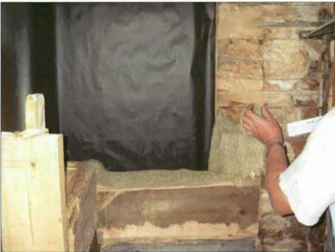
Yläkuvassa olevan nurkan tekovaiheita. Saumat tilkittiin pellavariiveellä.
