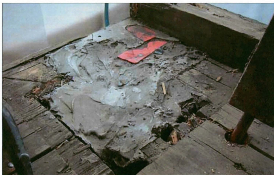
Korjaustyön aluksi eteläkulman pilarin alta piti etsiä kovaa puuta. Pileri oli edellisen kerran korjattu Plastic Padding -massalla.
