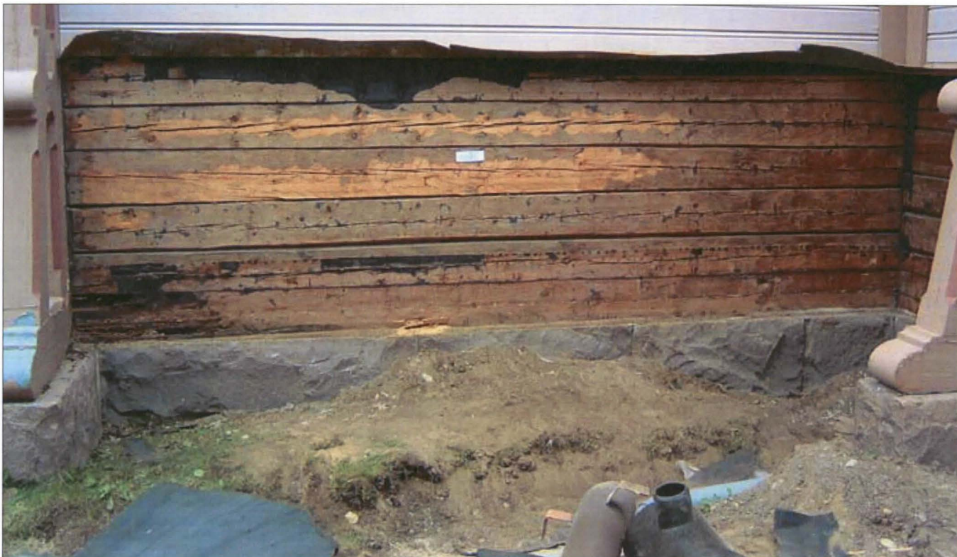
Kaakkoiseteisen ulkoseinän alaosassa laho- ja hyönteisvaurioita.
