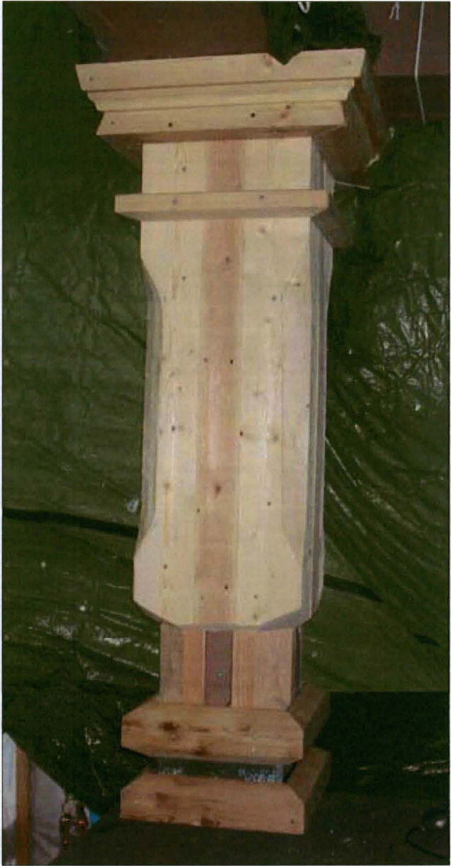
Uusi pilari verhottuna ja listoitettuna. Pilarin yläpään kruunu pellitettiin, kuten alunperinkin oli tehty. Listoituksen yläreuna tulisi kitata maalauksen yhteydessä.
