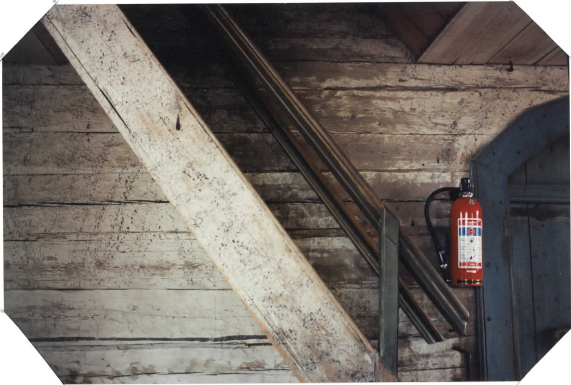
PORTAIKKO ENNEN RESTAUROINTIA
