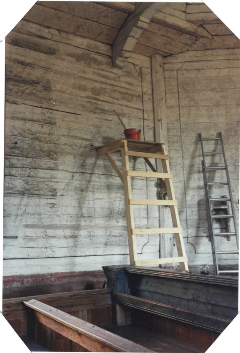
SAMA SEINÄNOSAA TYÖVAIHEESSA
