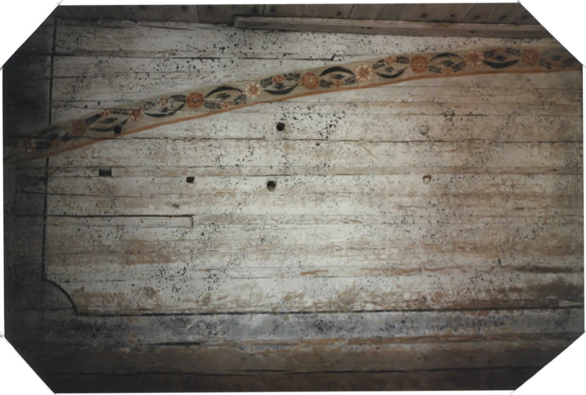
ENNEN RESTAUROINTIA POHJ.
