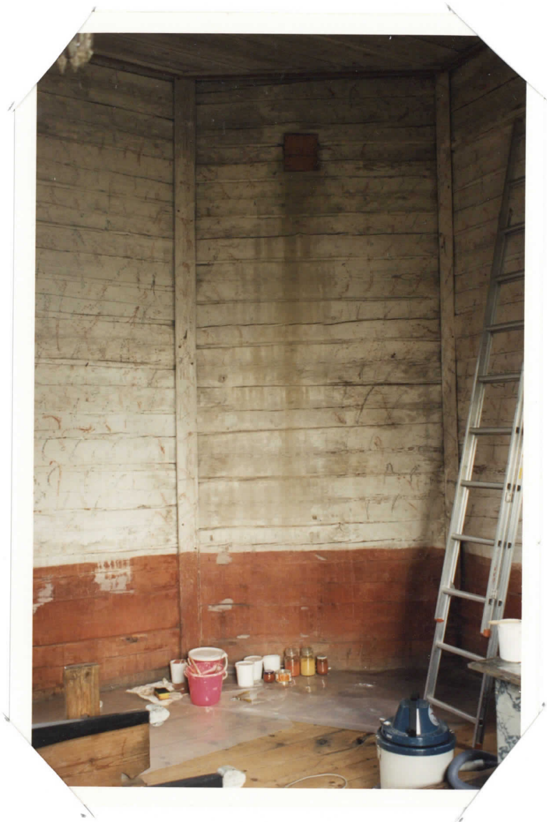
OSA SEINÄPINTAA ENNEN Puhdistusta - ja RESTAUROINTIA
