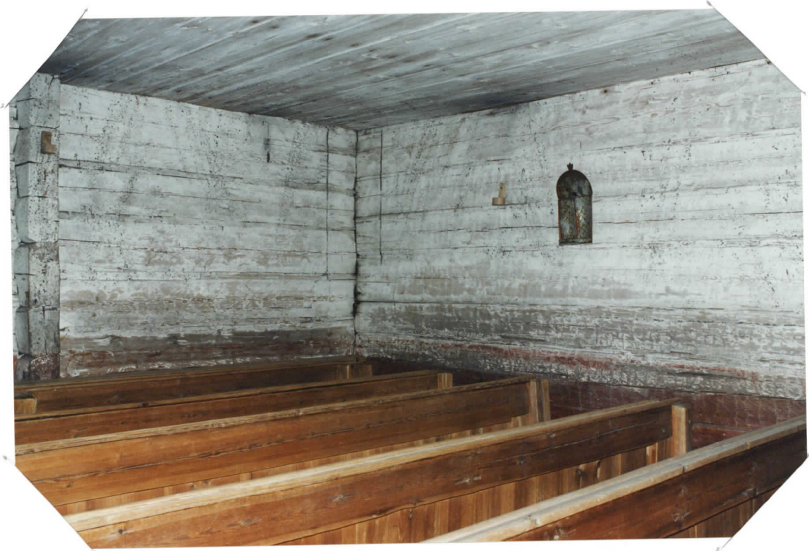
SEINÄPINTAA ENNEN RESTAUROINTIA, LEHT. ALUS
